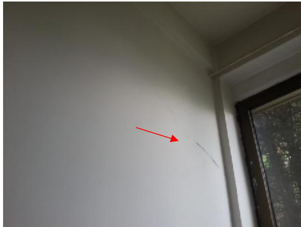
Slika 94 – Kosa pukotina u zidu u osi “F” između osa “10” i “11” (muški toalet za osoblje škole) (foto 140)
