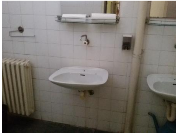
Slika 93 – Oštećene zidne pločice; radijatori i cevi u lošem stanju; neispravna slavina (foto 138)
