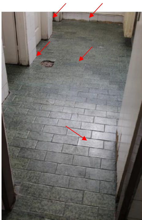
Slika 77 – Oštećenja na zidnoj i podnoj keramici; vrata u lošem stanju; odvod u lošem stanju (ženski toalet za u enike) (foto 106)
