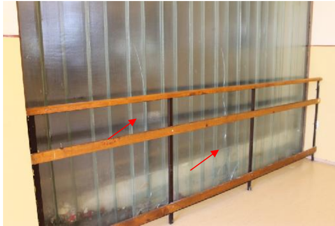
Slika 35 – Oštećenje svetlarnika u osi “Q” izme u osa “5” i “7” (foto 45)
