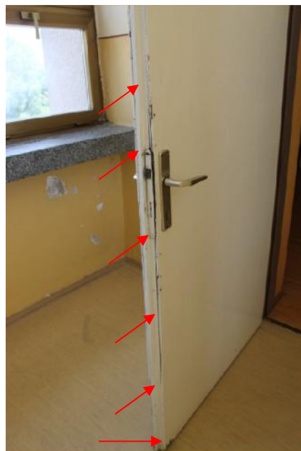
Slika 45 – Oštećenja vrata (u ionica srpskog jezika) (foto 57)
