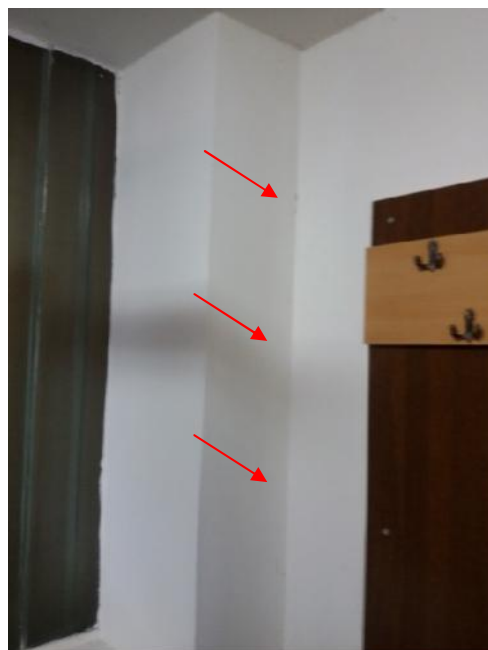
Slika 100 – Pojava vertikalne prsline na zidu u osi “H” izme u osa “13” i “14” (foto 151)
