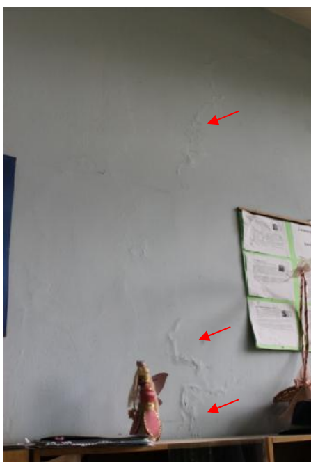
Slika 146 – Pojava vlage na zidu u osi “Z” izme u osa “3” i “5” (u ionica IV razreda) (foto 150)
