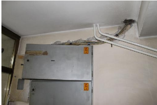
Slika 188 – Odlamanje maltera usled lošeg štemanja u zidu u osi “13” izme u osa “C” i “D”; (hodnik) (foto 201)
