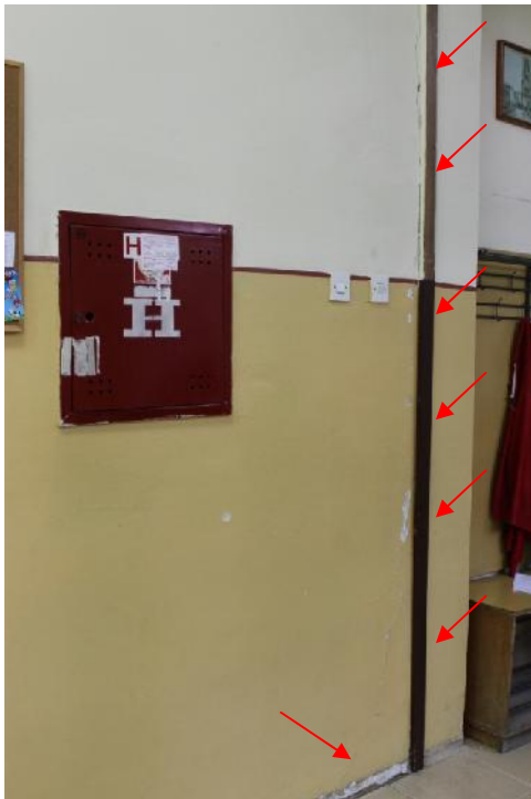
Slika 156 – Vertikalna pukotina na mestu dilatacije u osi “4” izme u osa “F” i “G”; odlomljena lajsna izme u zida u osi “4” i poda (hodnik) (foto 162)
