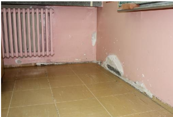
Slika 119 – Odlomljene lajsne izme u zidova u osama “G” i “I” i poda; ošte enje površinskog sloja zida i odlamanje maltera (u ionica I i II razreda) (foto 119)
