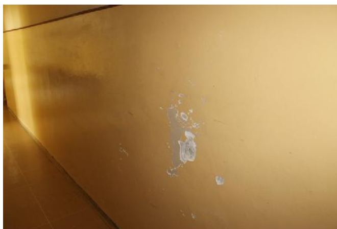
Slika 21 – Oštećenje površinskog sloja i otpadanje maltera u zidu u osi “5” između osa “J” i “K” (foto 28)
