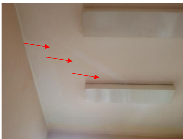
Slika 98 – Uočena ranije sanirana kosa pukotina na plafonu između osa “10” i “11” i (kancelarija sekretarice) (foto 148)
