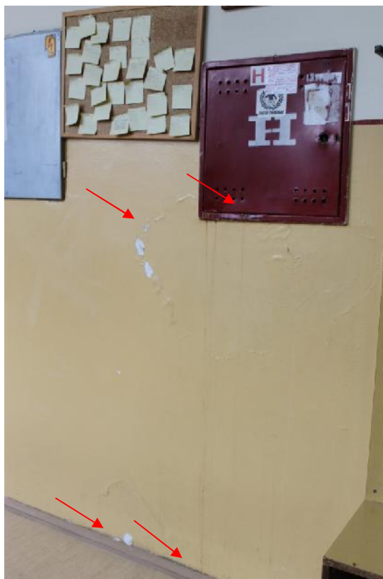
Slika 152 – Ošte enje površinskog sloja zida u osi “6” izme u osa “V” i “W”; ošte enje hidrantskog zidnog ormara; ošte ene podne lajsne (hodnik) (foto 157)
