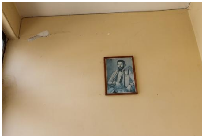
Slika 52 – Horizontalna pukotina i odlamanje maltera u zidu u osi “Z” izme u osa “6” i “7” (foto 67)
