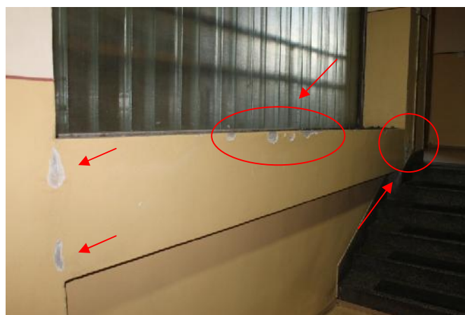
Slika 118 – Skidanje površinskog sloja zida i odlamanje maltera u zidu u osi “Q” između osa “5” i “7” (foto 241)
