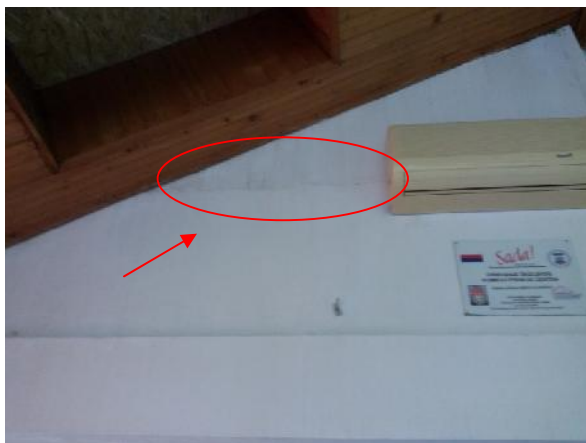
Slika 105 – Horizontalna pukotina u zidu u osi “I3” između osa “I” i “K” (kabinet informatike) (foto 158)
