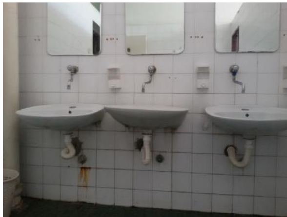
Slika 198 – Oštećena zidna i podna keramika; umivaonici u lošem stanju u osi “P” između osovina “11” i “12” (foto 180)
