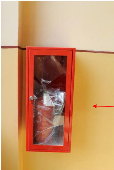
Slika 29 – Oštećen zidni ormar aparata za ručno gašenje požara na zidu u osi “Q” (foto 37)
