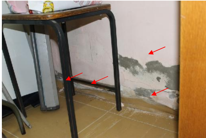
Slika 134 – Oštećenja na zidu i podu, površinska oštećenja i odlamanje maltera u zidu u osi “Q” izmeću osa “3” i “4” (stružba na službu) (foto 137)
