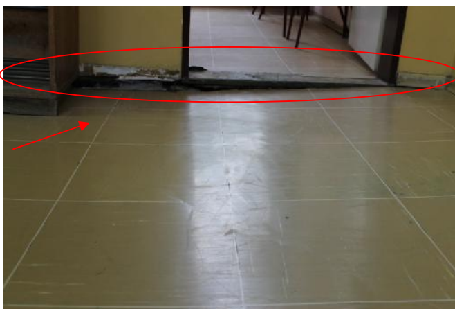
Slika 154 – Ugib podne konstrukcije izme u osa “4” i “5” i osa “E” i “G”; (hodnik) (foto 159)
