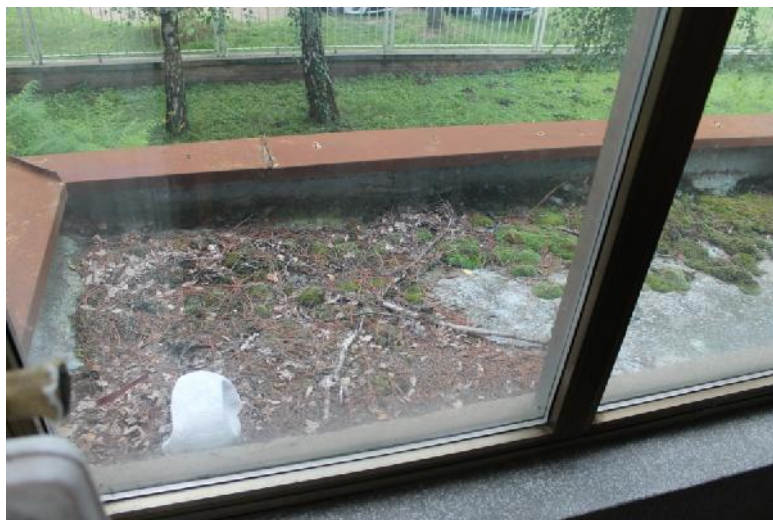
Slika 191 – Prikaz lošeg stanja ravnog krova iznad ulaza u objekat izme u osa “12” i “13”(foto 204)
