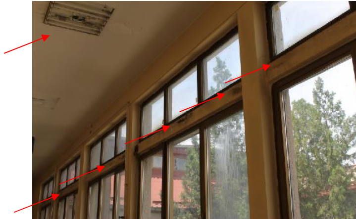
Slika 56 – Pojava kondenza na horizontalnoj gredi izme u prozora u osi “7” izme u osa “T” i “Z”; ošte ene lampe sa neonkama (foto 69)
