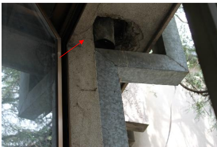
Slika 60 – Detalj prekida olu ne vertikale (koja više nije u funkciji) i postavljanje novog oluka – slabo mesto u konstrukciji (u ionica likovnog) (foto 77)
