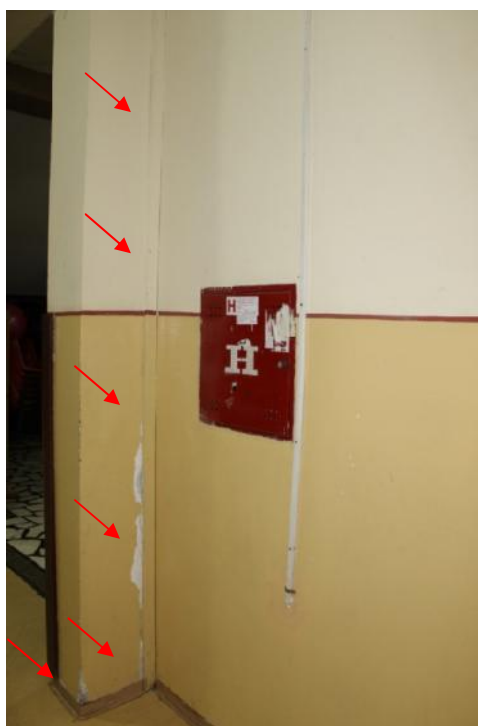
Slika 184 – Vertikalna pukotina i površinsko ošte enje stuba na mestu dilatacije u osi “10” izme u osa “L” i “M” (hodnik) (foto 196)
