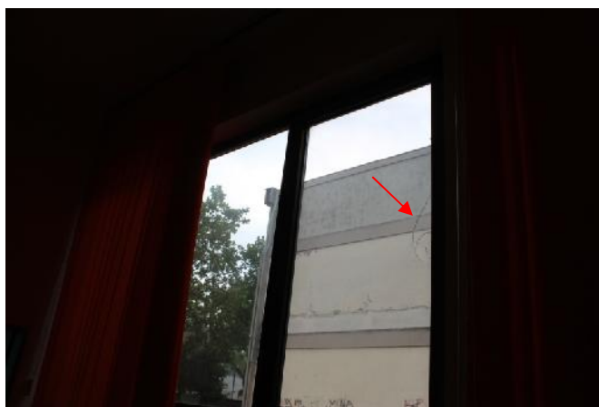
Slika 169 – Ošte eno staklo na prozoru (hodnik - produženi boravak) (foto 178)
