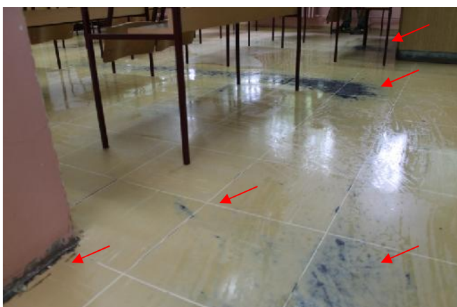
Slika 121 – Odlomljena lajsna izme u zida i poda i ošte enje poda (u ionica I i II razreda) (foto 123)
