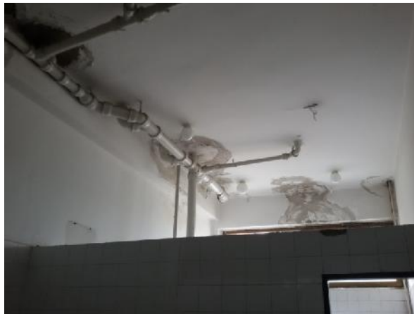
Slika 195 – Površinsko oštećenje i odlamanje maltera zidova i plafona izme u osa “11” i “13” (foto 174)
