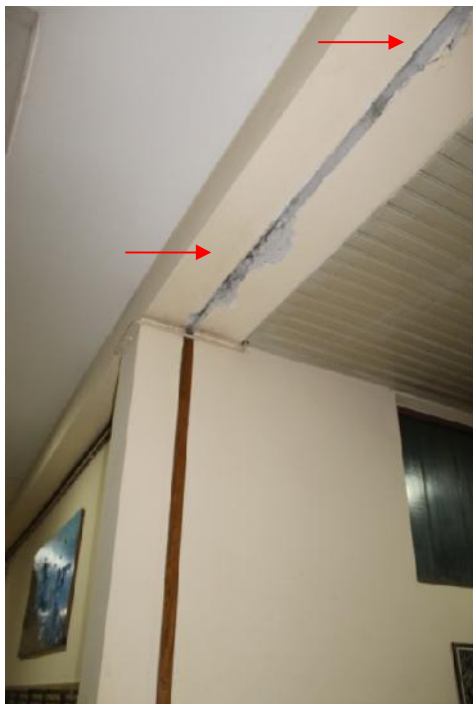
Slika 108 – Oštećenje grede na mestu dilatacije u osi “10” između osa “P” i “Q” (foto 230)
