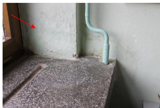
Slika 74 – Pojava vlage na stubu u osi “13” kod donje ivice prozora (pomo ni kabinet) (foto 100)
