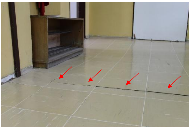
Slika 153 – Ugib podne konstrukcije izme u osa “4” i “5” i osa “E” i “G”; pukotina na mestu podne dilatacije (hodnik) (foto 158)
