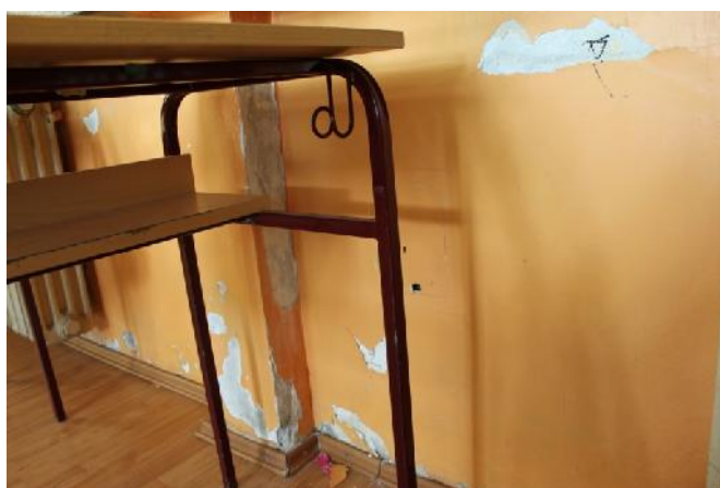
Slika 48 – Oštećenje površinskog sloja i otpadanje maltera u zidu u osi “7” izme u osa “Z” i “Š”(u ionica srpskog jezika)(foto 59)
