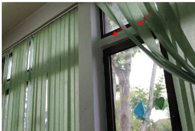
Slika 148 – Pojava vlage na horizontalnoj gredi izme u prozora u osi “4” izme u osa “Z” i “Š”; ošte enje površinskog sloja grede i otpadanje maltera na pojedinim mestima (u ionica IV razreda) (foto 152)
