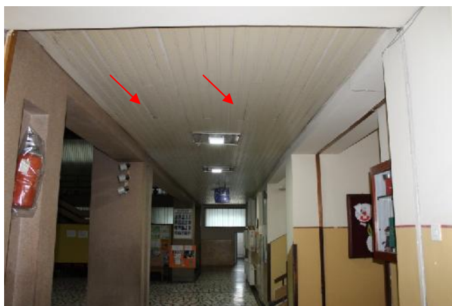
Slika 166 – Oštećenje plafonske obloga (foto 175)
