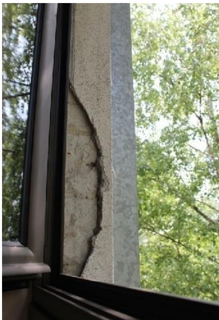
Slika 33 – Oštećenje fasade na mestu zida u osi “1” između osa “M” i “N” (u ionica) (foto 42)
