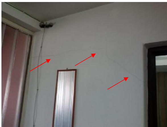
Slika 102 – Pukotina u zidu (po celoj debljini zida) (kancelarija uz kabinet informatike) (foto 153)
