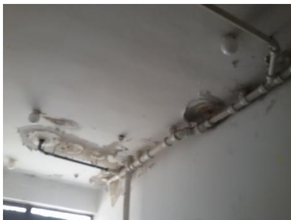
Slika 199 – Površinsko oštećenje i odlamanje maltera zidova i plafona između osovina “11” i “13” (foto 182)
