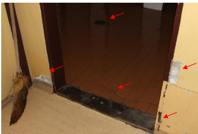
Slika 143 – Podna keramika i odvod u lošem stanju; oštećena ulazna vrata (ženski toalet) (foto 146)
