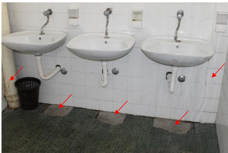
Slika 76 – Oštećena zidna keramika; nedostaje deo podne keramike; pojedini umivaonici nisu u funkciji; cevi u lošem stanju (ženski toalet za učenike) (foto 104)
