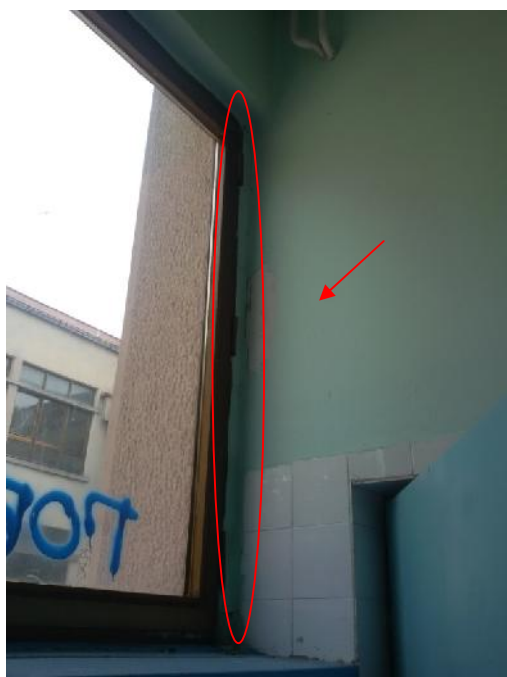
Slika 192 – Vertikalna pukotina i površinsko oštećenje zida u osi “X”(toalet u produženom boravku) (foto 165)
