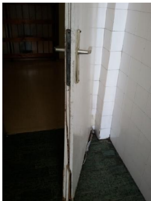
Slika 80 – Oštećenja na vratima u ulazu u toalet (muški toalet za u enike) (foto 127)
