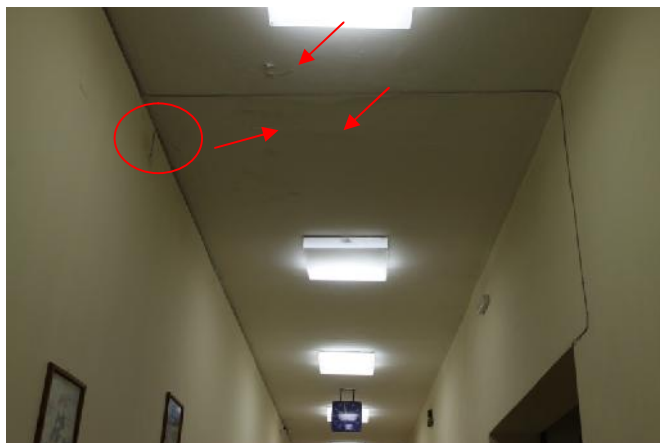
Slika 162 – Površinsko oštećenje plafona izme u osa “4” i “5”; rupe nastale lošim razvodom instalacija (hodnik) (foto 171)
