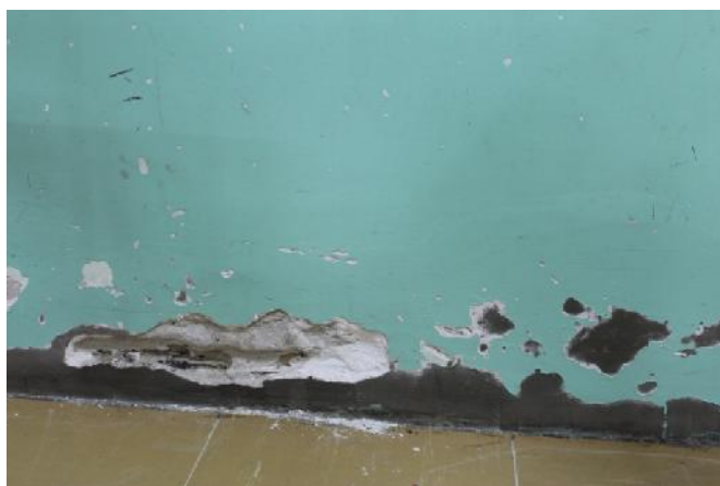
Slika 132 – Odlomljena lajsna izme u zida i poda, površinsko ošte enje i odlamanje maltera u zidu u osi “4” izme u osa “N” i “O” (u ionica I i II razreda) (foto 135)
