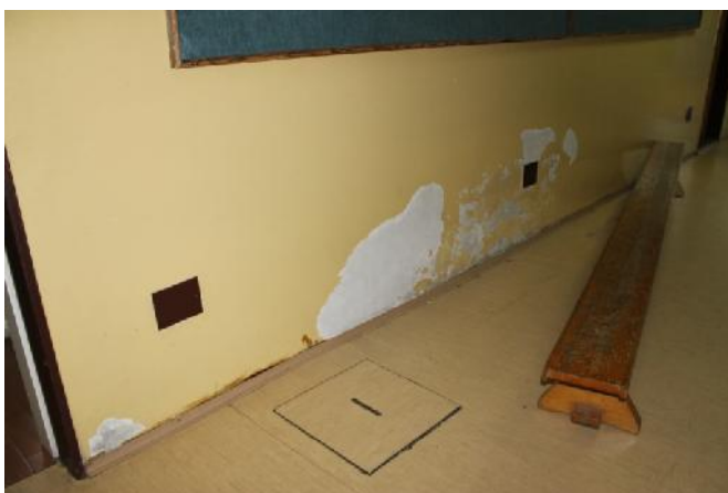
Slika 186 – Površinsko oštećenje i otpadanje maltera na zidu u osi “H” izme u osa “14” i “15”; oštećenje lajsna izme u zida u osi “H” i poda (hodnik) (foto 199)
