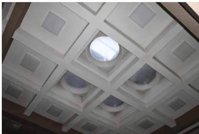
Slika 113 – Prikaz kasetirane tavanice (foto 234)
