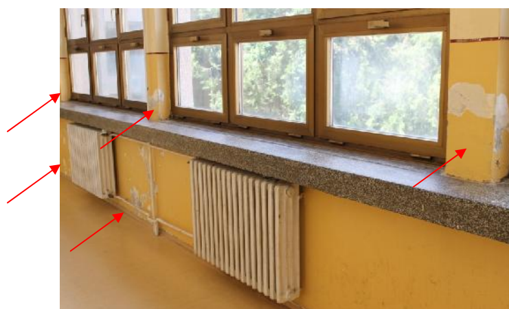
Slika 55 – Ošte enje površinskog sloja i odlamanje maltera na parapetu spoljašnjeg zida u osi “7” izme u osa “T” i “Z” i donjem delu stubova; (foto 68)
