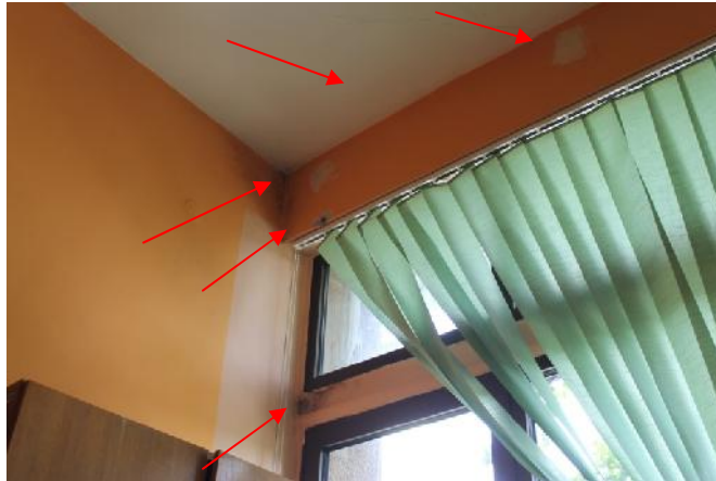
Slika 50 – Pojava kondenza na horizontalnoj gredi izme u prozora u osi “4” izme u osa “Z” i “Š” i na spoju spoljašnjih zidova u osi “4” i “Š” i tavanice; kose prsline na tavanici; odlamanje maltera na zidu u osi “4” (u ionica srpskog jezika) (foto 62)
