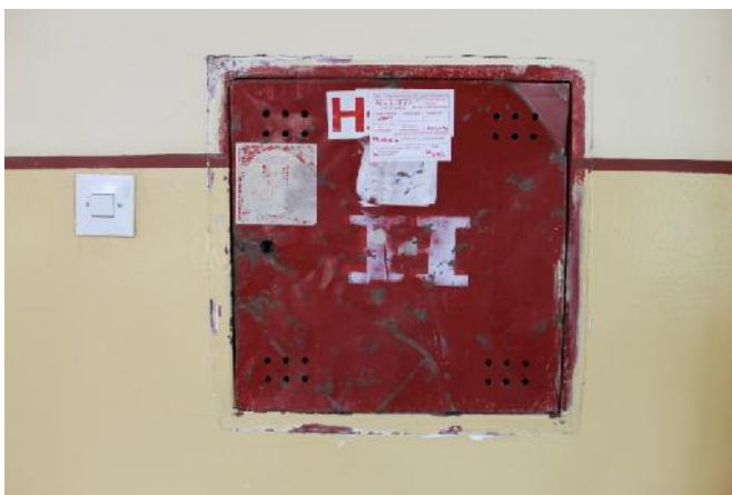
Slika 18 – Ošte enje zidnog hidrantskog ormara u osi “4” (foto 25)
