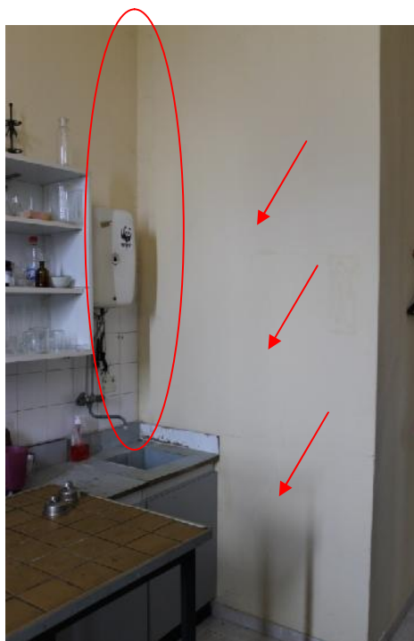
Slika 68 – Vertikalne prsline po celoj visini prostorije na zidu i vertikalna prslina na mestu susticanja sa zidom u osi “X” (kabinet hemije) (foto 87)
