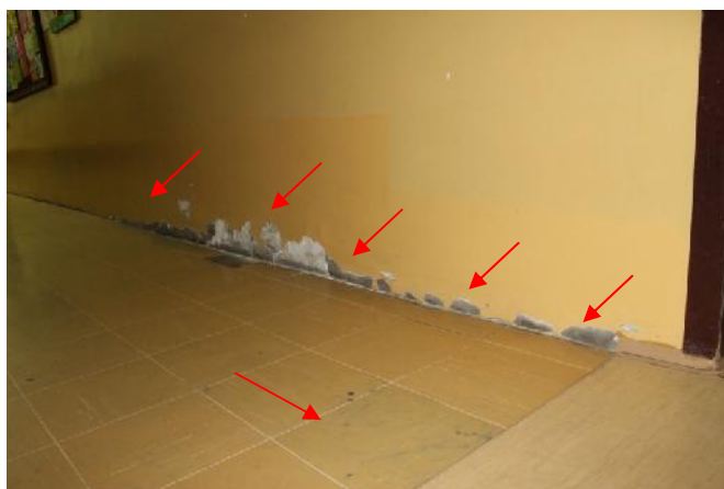
Slika 163 – Odlomljena lajsna izme u zida i poda, površinsko oštećenje i odlamanje maltera u zidu u osi “5” izme u osa “N” i “P” (hodnik) (foto 172)
