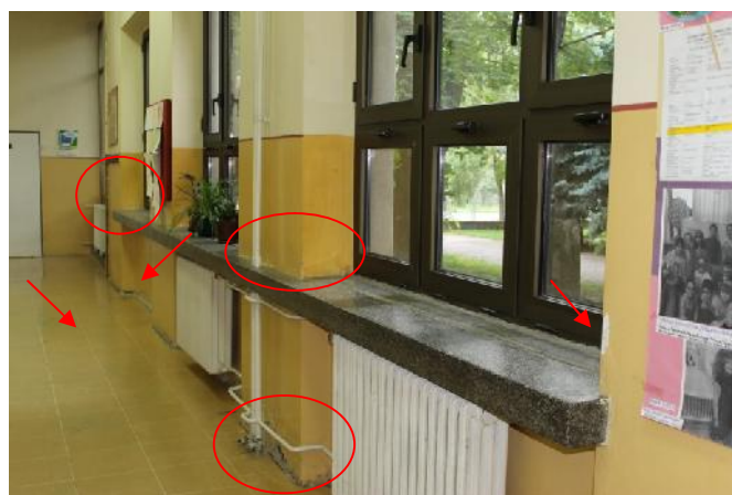
Slika 160 - Pojava vlage na svim stubovima kod donje ivice prozora u osi “5” između osa “E” i “J”; oštećenje površinskog sloja zida i otpadanje maltera; odlomljena lajsna na spoju sa podom (hodnik) (foto 168)
