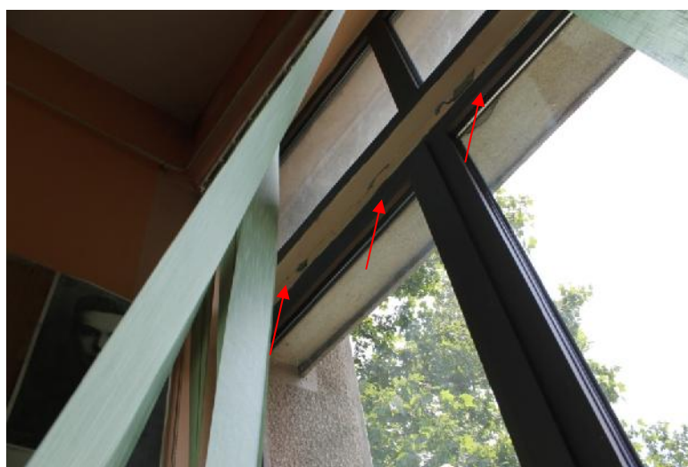
Slika 46 – Pojava kondenza i odlamanje maltera na horizontalnoj gredi između u prozora u osi “3” između u osa “X” i “Z”(u ionica srpskog jezika) (foto 55)
