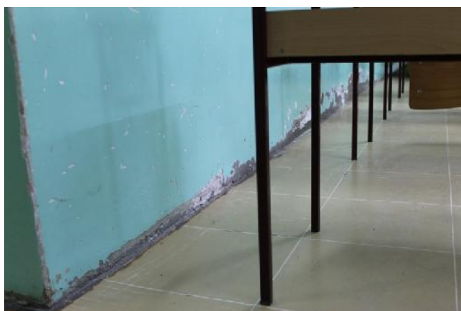
Slika 130 – Odlomljena lajsna izme u zidova u osi “4” izme u osa “M” i “P” i poda; površinsko oštećenje zida (u ionica I i II razreda) (foto 133)
