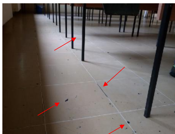
Slika 64 – Ošte en pod (u ionica geografije) (foto 163)
