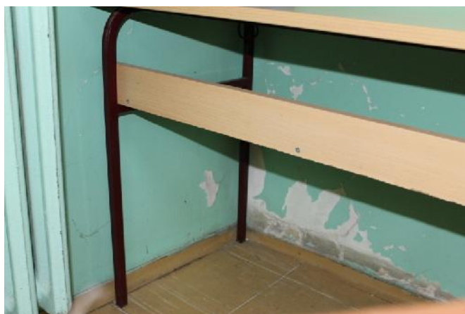
Slika 129 – Oštećenje površinskog sloja zidova i odlamanje maltera u osama “I” i “M” (u ionica I i II razreda) (foto 132)
