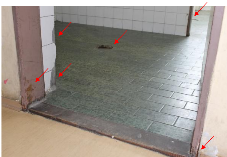
Slika 75 – Oštećena zidna i podna keramika; vrata u lošem stanju; odvod u lošem stanju (ženski toalet za učenike) (foto 103)
