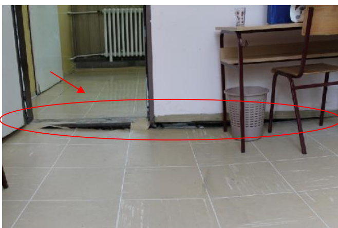
Slika 155 – Ugib podne konstrukcije izme u osa “2” i “4” i osa “E” i “G”; (arhiva) (foto 160)
