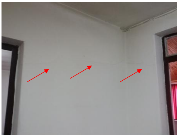
Slika 103 – Pukotina u zidu (po celoj debljini zida) (kancelarija uz kabinet informatike) (foto 154)
