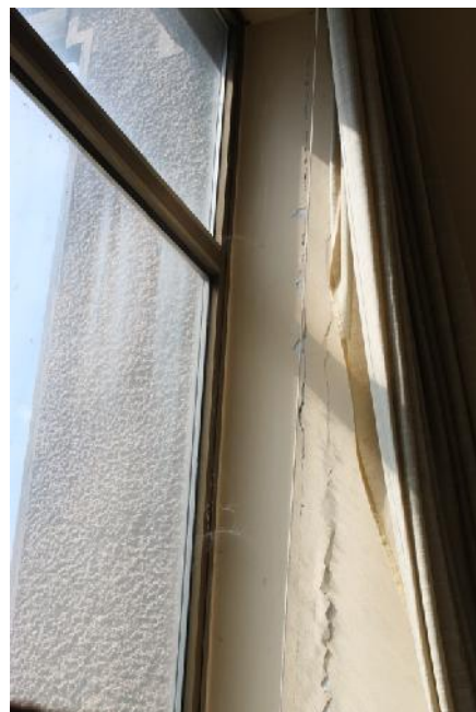
Slika 5 – Vertikalne pukotine na spoju zidova u osi “E” i osi “2” (pomoćni kabinet) (foto 5)
