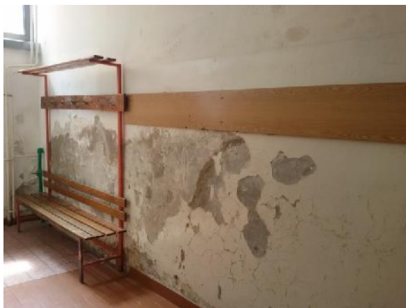
Slika 207 – Površinsko oštećenje i odlamanje maltera zida izme u osa “F” i “H” (muška svla ionica) (foto 203)
