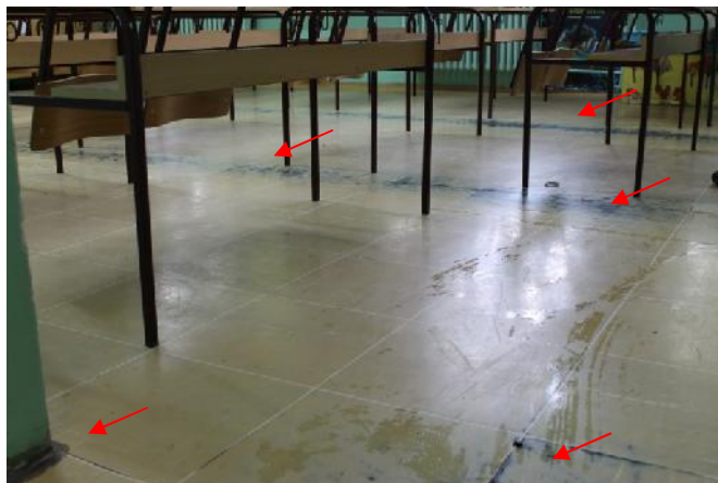
Slika 131 – Odlomljena lajsna izme u zida i poda i ošte enje poda (u ionica I i II razreda) (foto 134)
