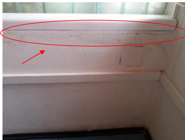
Slika 106 – Horizontalna pukotina na parapetu zida u osi “I5” između osa “J” i “K” (kabinet informatike) (foto 159)
