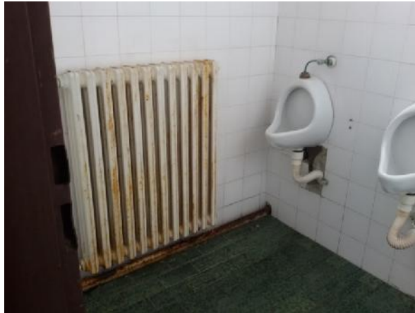
Slika 204 – Loše stanje radijatora, cevi, zidne i podne keramike u muškom toaletu (foto 189)
