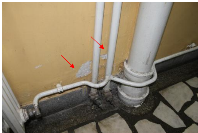
Slika 168 – Površinsko ošte enje zida u osi “Q” izme u osa “8” i “10” (hodnik) (foto 177)
