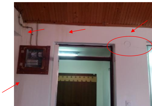
Slika 104 – Vertikalna prslina i horizontalna prslina u uglu vrata u zidu u osi “I” izme u osa “13” i “14”; pojava vlage na mestu spoja zida i tavanice (kabinet informatike) (foto 157)
