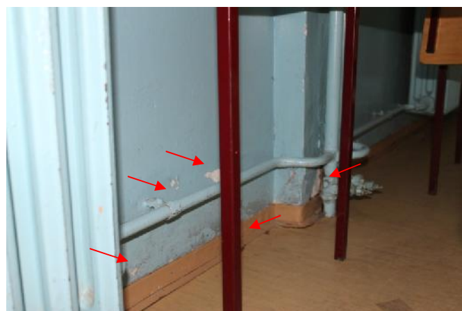
Slika 147 – Ošte ena lajsna, ošte eni površinski sloj zida u osi “3”; otpadanje maltera (u ionica IV razreda) (foto 151)
