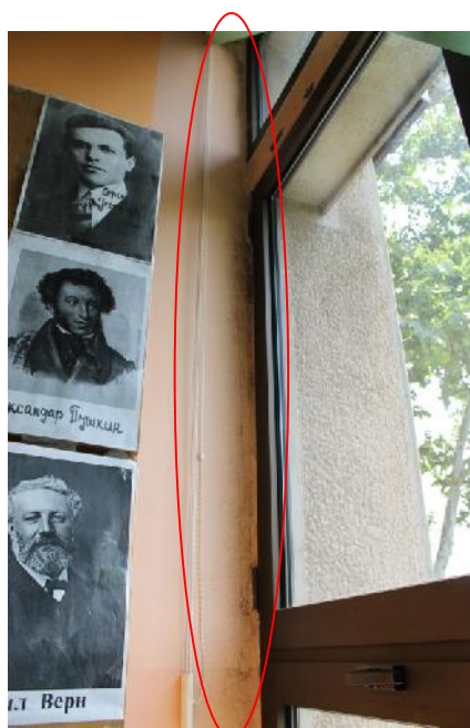
Slika 44 – Pojava kondenza na zidu u osi “Z” uz vertikalnu prozora (u ionica srpskog jezika) (foto 54)
