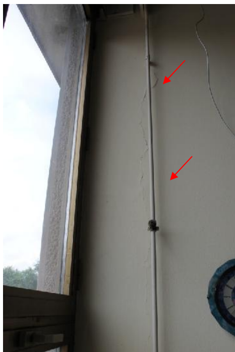
Slika 71 – Vertikalna prslina na zidu u osi “W” na mestu ukrstanja sa osom “13” (u ionica hemije) (foto 97)
