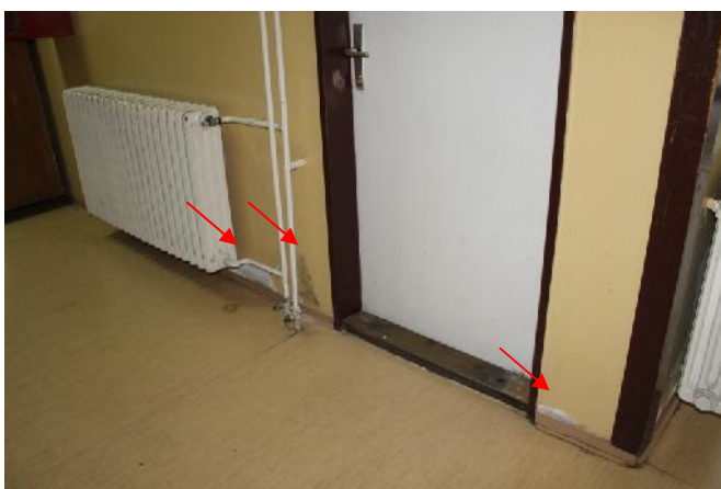
Slika 187 – Površinsko oštećenje zida u osi “I” izme u osa “14” i “15”; oštećenje lajsna izme u zida u osi “I” i poda (hodnik) (foto 200)
