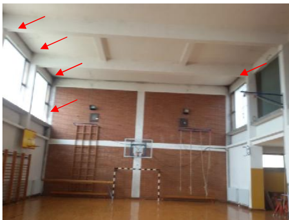
Slika 214 – Pojava kondenza na mestu spoja spoljašnjih zidova i tavanice i me usobnog spoja spoljašnjih zidova(sportska hala) (foto 249)
