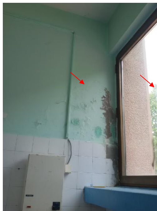
Slika 193 – Površinsko oštećenje zida i zidne keramike u osi “Y”; oštećenje stakla na prozoru (toalet u produženom boravku) (foto 166)
