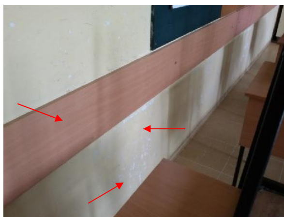
Slika 63 – Ošte enje površinskog sloja zida u osi “4” izme u osa “J” i “M”; postavljen drveni element radi spre avanja ošte enja zida na spoju sa a kom klupom (u ionica geografije) (foto 162)
