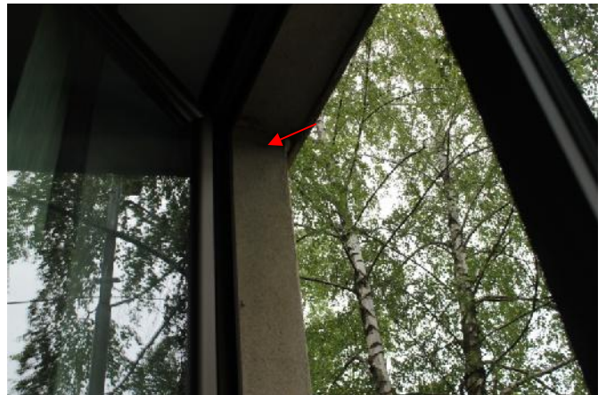
Slika 123 – Uoči ko i i na mestu spoja otvora i prozora na zidu u osi “I” izme u osa “K” i “L” (u ionica I i II razreda) (foto 124)
