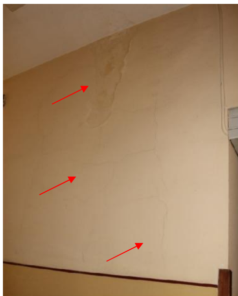
Slika 20 – Mrežaste pukotine na zidu u osi “5” između osa “K” i “L” (foto 27)
