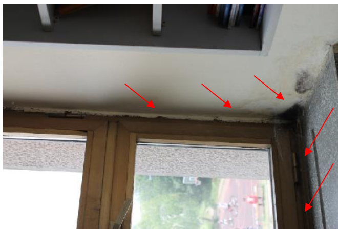
Slika 65 – Pojava kondenza na spoju spoljašnjih zidova u osi “X” i osi “13” i tavanice; pojava vlage na tavanici (kabinet hemije) (foto 83)
