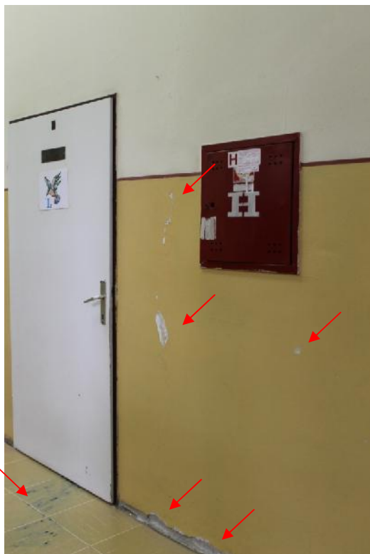
Slika 159 – Vertikalna pukotina u osi “4” između osa “G” i “H”; oštećenje površinskog sloja zida; odlomljena lajsna na spoju sa podom; oštećenje pod (hodnik) (foto 167)
