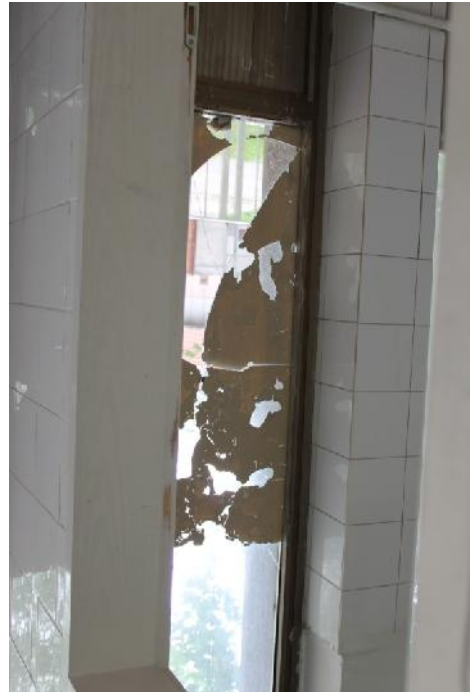
Slika 137 – Polomljeno staklo prozora u osi “3” (muški toalet) (foto 141)
