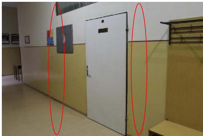
Slika 183 – Vertikalne pukotine u osi “11” izme u osa “K” i “L” (hodnik) (foto 195)
