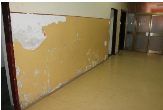
Slika 180 – Površinsko oštećenje zida i otpadanje maltera u osi “11” između osa “Q” i “U” (hodnik) (foto 192)
