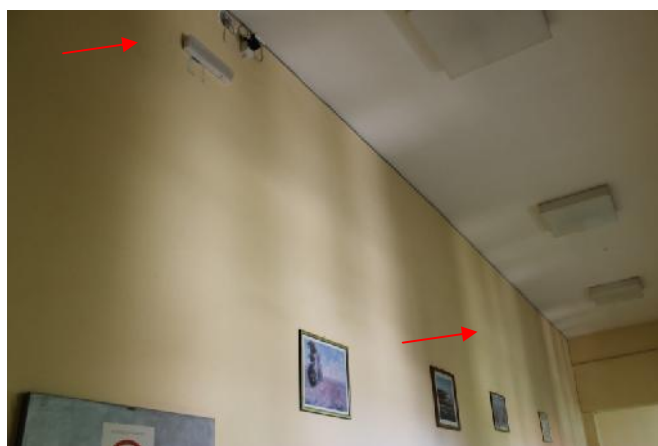
Slika 19 – Ošte enje zida u osi “4” izme u osa “H” i “J” rupe nastale lošim razvodom instalacija (foto 26)
