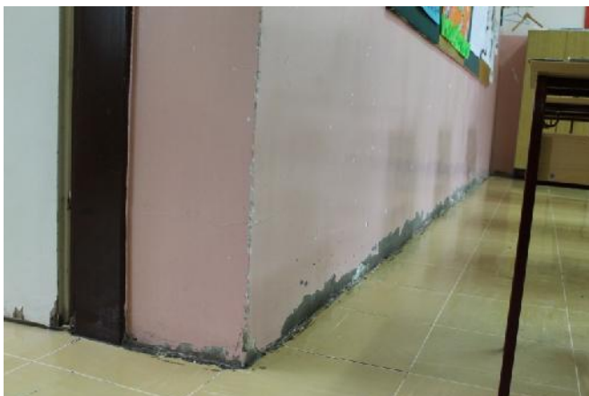
Slika 120 – Odlomljena lajsna izme u zidova u osi “4” izme u osa “G” i “J” i poda; površinsko ošte enje zida (u ionica I i II razreda) (foto 121)
