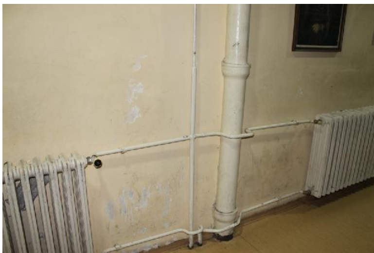
Slika 110 – Oštećenje površinskog sloja zida u osi “Q” između osa “8” i “10”; prikaz cevi i radijatora (foto 232)
