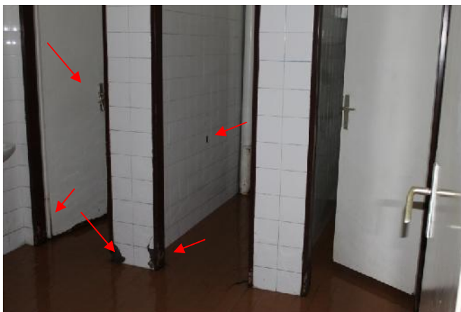
Slika 142 – Podna i zidna keramika i odvod u lošem stanju; oštećena vrata na ulazu u WC kabine (ženski toalet) (foto 145)
