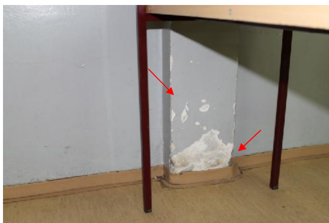
Slika 149 – Ošte ena lajsna izme u zida i poda, površinsko ošte enje i odlamanje maltera u zidu u osi “7” izme u osa “Z” i “Š” (u ionica IV razreda) (foto 153)
