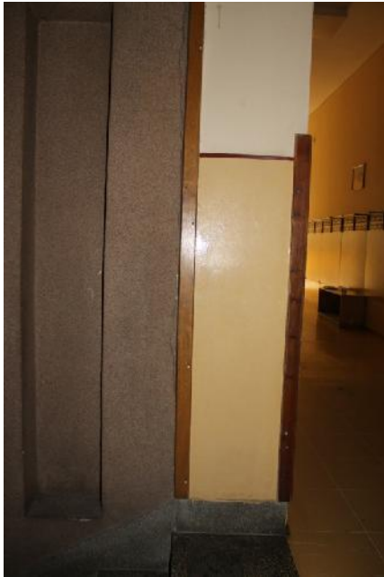
Slika 22 - Pukotina na mestu zidne dilatacije na zidu u osi “5”(foto 30)
