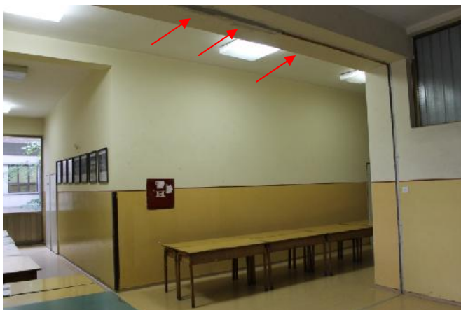
Slika 185 – Prikaz dilatacije i površinsko oštećenje grede na mestu dilatacije osi “13” izme u osa “H” i “J”; oštećenje lajsna izme u zida u osi “H” i poda (hodnik) (foto 198)
