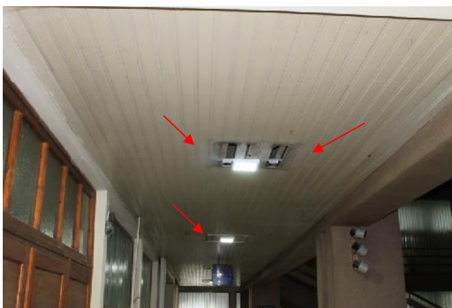
Slika 161 – Oštećenje lampe sa neonkama i plafonska obloga (foto 120)
