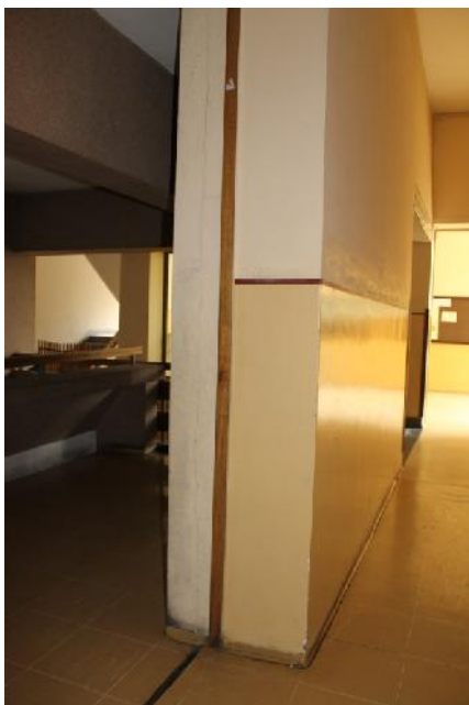
Slika 24 - Pukotina na mestu zidne dilatacije na zidu u osi “5”(foto 32)
