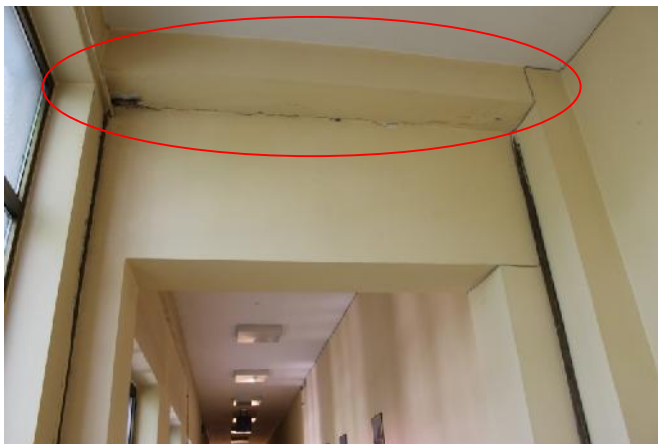
Slika 17 – Ošte enje grede u osi “G” na mestu dilatacije, izme u osa “4” i “5” (foto 23)
