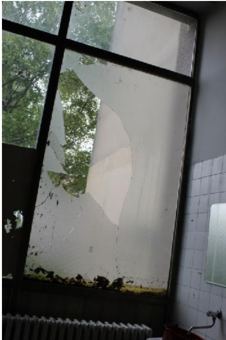
Slika 136 – Polomljeno staklo prozora u osi “3” (muški toalet) (foto 139)
