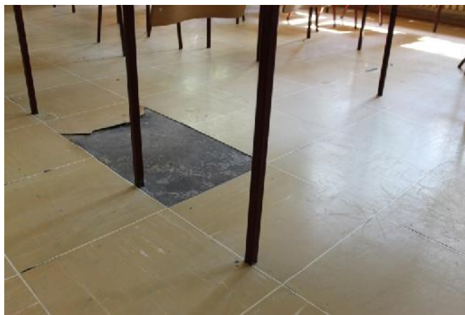
Slika 31 – Oštećen pod (u ionici) (foto 40)
