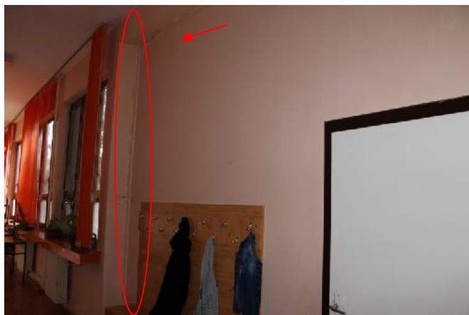
Slika 172 – Vertikalna pukotina na stubu na mestu ukrštanja osa “10” i “T”; površinsko oštećenje zida (hodnik – produženi boravak) (foto 182)
