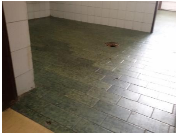
Slika 194 – Loše stanje zidne i podne keramike i odvoda u ženskom toaletu izme u osa “11” i “13” (foto 173)
