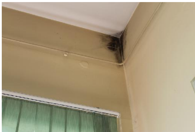
Slika 12 – Pojava kondenzata na spoju spoljašnjih zidova u osi “G” i osi “1” i tavanice (u ionica) (foto 17)
