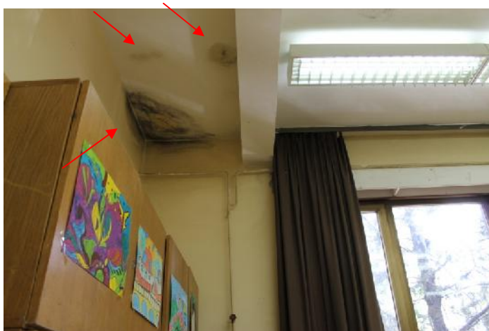
Slika 61 – Pojava kondenza na spoju spoljašnjih zidova u osi “T” i osi “10” i tavanice; pojava vlage na tavanici (u ionica likovnog) (foto 79)
