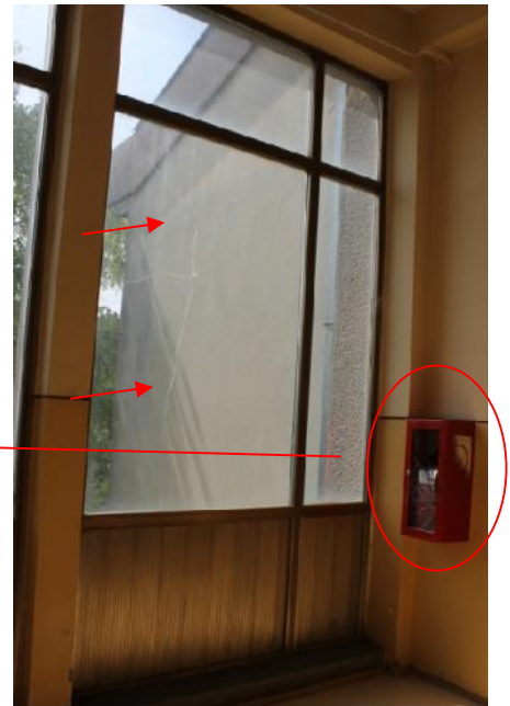
Slika 30 – Oštećeno staklo prozora u osi “3” između osa “Q” i “R” (foto 38)
