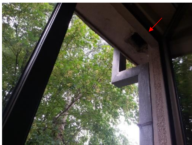
Slika 89 – Oštećenje na fasadi objekta na mestu prekida nekadašnje olu ne vertikale i postavljanje novog oluka – slabo mesto u konstrukciji (biblioteka) (foto 121)
