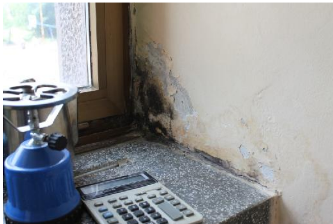
Slika 85 – Pojava vlage na zidu u osi “Y” između osa “12” i “13” (ra unovodstvo) (foto 115)
