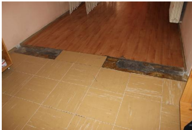
Slika 171 – Ošte en pod i delimi no ošte ena cementna košuljica izme u osa “10” i “11” (hodnik – produženi boravak) (foto 181)
