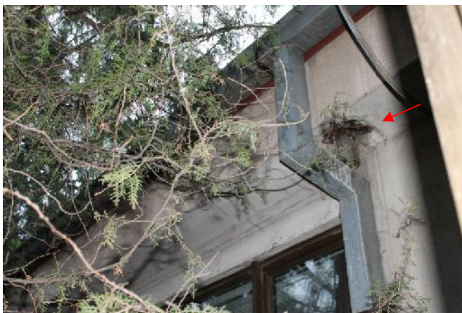
Slika 116 – Oštećenje na fasadi objekta na mestu prekida nekadašnje olu ne vertikalne postavljajući novog oluka – slabo mesto u konstrukciji (foto 238)
