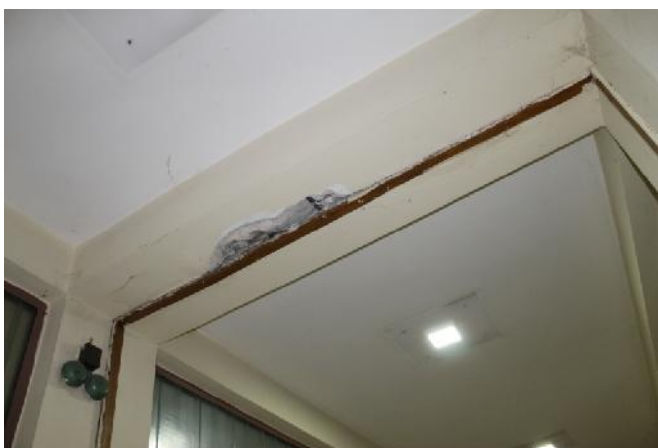
Slika 182 – Površinsko oštećenje grede i otpadanje maltera na mestu dilatacije u osi “10” između osa “P” i “Q” (hodnik) (foto 194)
