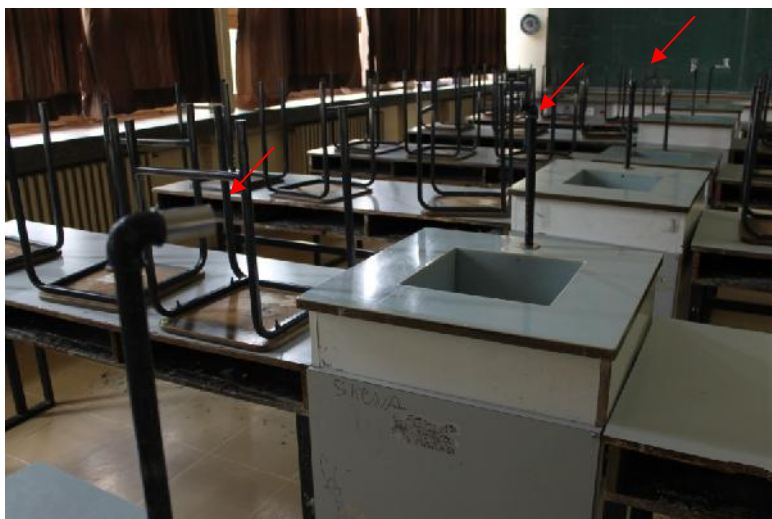
Slika 72 – Uo eno nepostojanje slavina (u ionica hemije) (foto 97)
