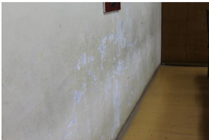
Slika 59 – Oštećenje površinskog sloja zida u osi “Q” između osa “8” i “10” (u ionica likovnog) (foto 76)
