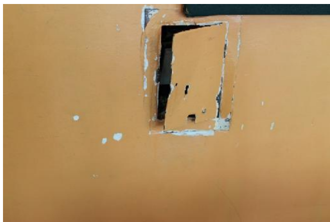
Slika 37 – Oštećenje maska za uti nicu (u ionica engleskog jezika) (foto 47)
