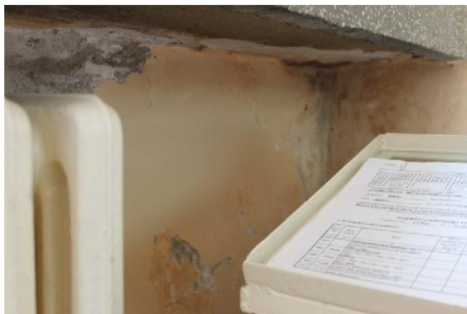
Slika 86 – Pojava vlage na parapetu zida između osa “X” i “Y” (ra unovodstvo) (foto 116)
