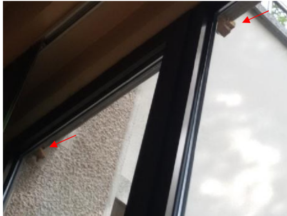
Slika 219 – Prikaz zaostalih ko i a na spoju prozora i konstrukcije objekta u osi “J” izme u osa “6” i “8”(u ionica muzi kog) (foto 262)
