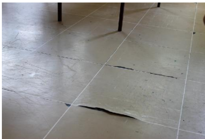
Slika 13 – Oštećenje podne ploče (u ionica) (foto 18)
