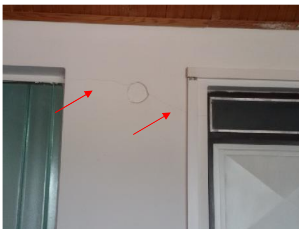
Slika 107 – Kosa pukotina u uglu vrata u zidu u osi “I” između osa “I4” i “I5” (kabinet informatike) (foto 160)
