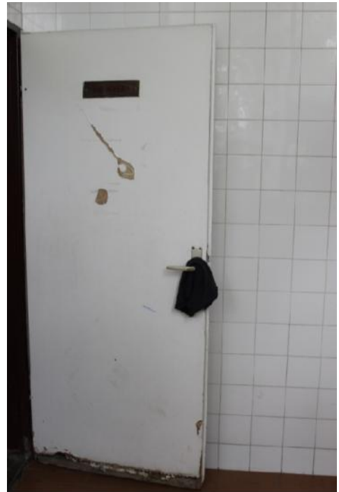
Slika 140 – Polomljena ulazna vrata u muški toalet u osi “Q”; (foto 143)
