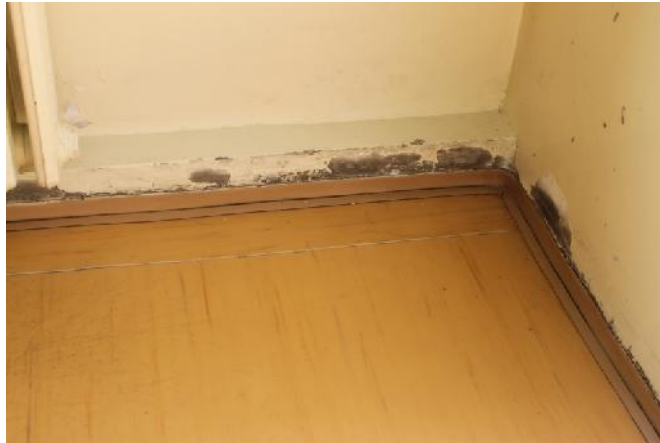
Slika 3 – Oštećenje zidova u osi “A” i osi “2” na mestu spoja sa podom (u ionica istorije) (foto 4)
