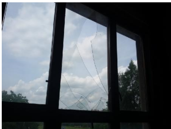
Slika 92 – Polomljeno staklo prozora u osi “13” (foto 137)
