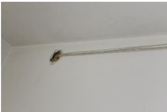
Slika 26 – Oštećenje zida u osi “4” između osa “P” i “Q” rupa i otpadanje maltera nastali lošim razvodom instalacija (foto 34)
