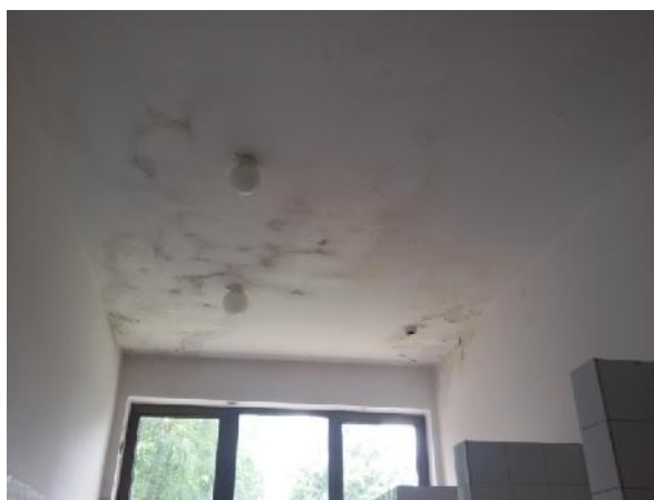
Slika 208 i Slika 209 – Oštećenja u ženskoj svla ionici - površinsko oštećenje i odlamanje maltera zida i plafona izme u osa “F” i “H” (foto 204 i foto 205)
