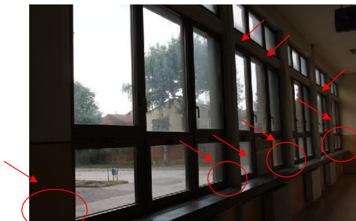
Slika 151 – Pojava vlage na horizontalnoj gredi izme u prozora u osi “7” izme u osa “U” i “Z”; ošte enje površinskog sloja grede i otpadanje maltera na pojedinim mestima; pojava vlage na svim stubovima u osi “7” kod donje ivice prozora; polomljno staklo na prozoru (hodnik) (foto 156)
