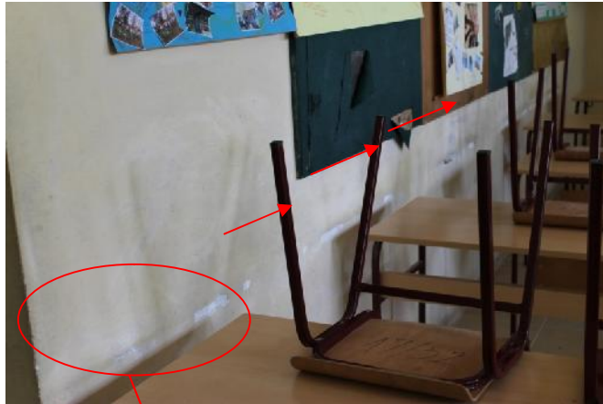
Slika 14 – Oštećenje zida u osi “4” izmeću osa “H” i “J” – rupe od akih klupa (u ionica) (foto 20)
