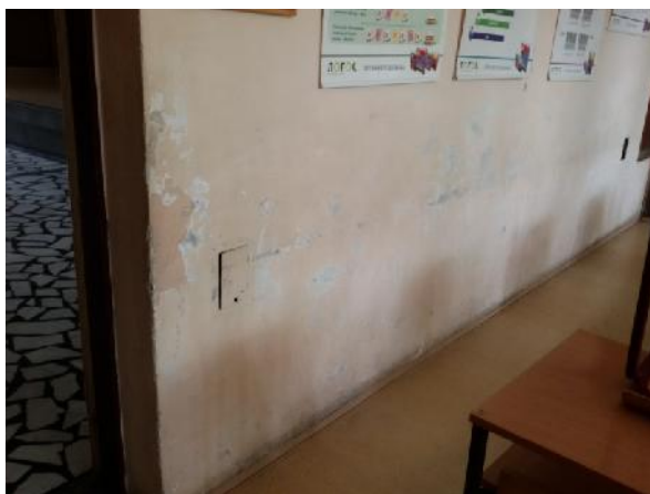
Slika 218 – Oštećenje površinskih slojeva zida u osi “L” između osa “5” i “7” (u ionici muzičkog) (foto 261)
