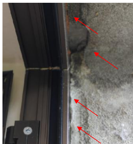
Slika 16 – Oštećenje zida u osi “1” – loše izveden spoj izmeću otvora i prozora (u ionica) (foto 22)
