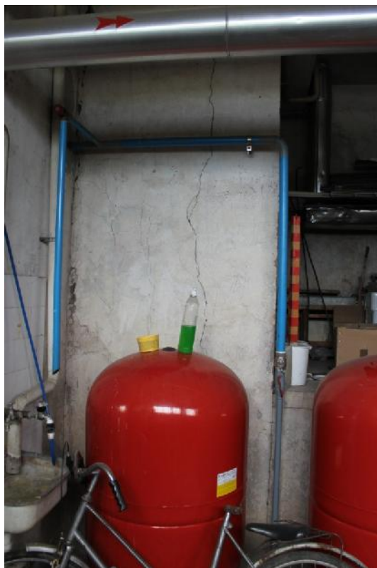
Slika 175 – Vertikalna pukotina i mrežaste prsline u zidu između osa “W” i “X”; (radionica) (foto 185)
