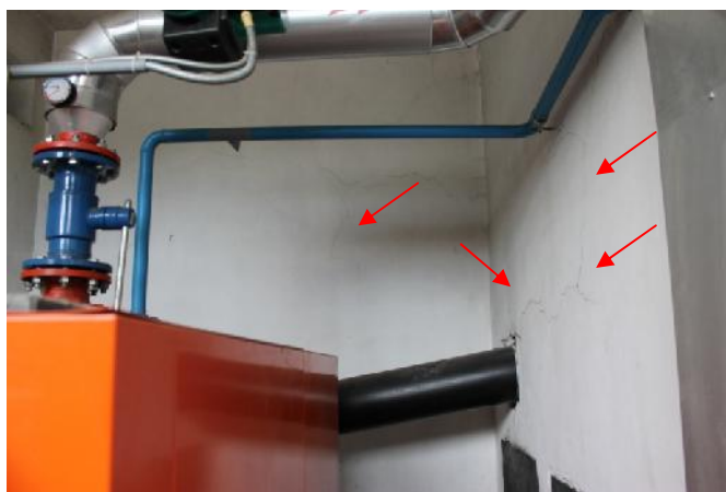
Slika 176 – Mrežaste prsline u zidovima u osama “10” i “X” (kotlarnica) (foto 186)
