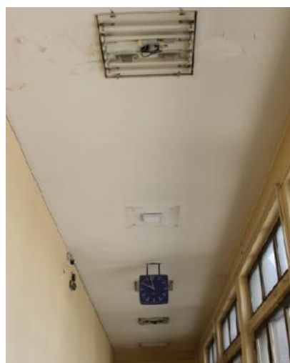
Slika 58 – Ošte ene lampe sa neonkama (foto 73)
