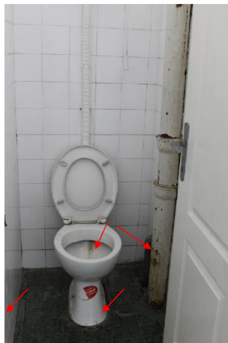
Slika 78 – Oštećenja na zidnoj i podnoj keramici; loše postavljena WC šolja te više nije u funkciji; cevi u lošem stanju (ženski toalet za u enike) (foto 108)
