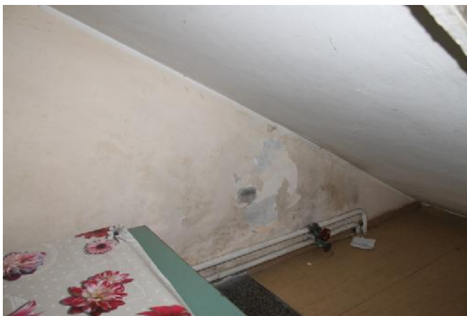
Slika 189 i Slika 190 – Površinsko oštećenje zida u osi “13” izme u osa “E” i “G”; (hodnik) (foto 200 i foto 201)
