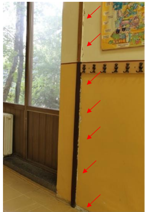
Slika 157 – Vertikalna pukotina na mestu dilatacije u osi “5” izme u osa “F” i “G”; odlomljena lajsna izme u zida u osi “4” i poda (hodnik) (foto 163)
