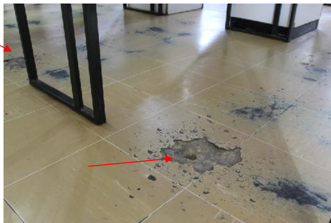
Slika 69 – Oštećen pod – uočene rupe u cementnoj košuljici (u ionica hemije) (foto 89)
