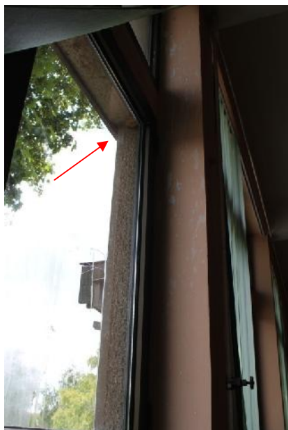
Slika 53 – Uo eni ko i i na mestu spoja otvora i prozora na zidu u osi “4” izme u osa “Z” i “Š”(u ionica srpskog jezika) (foto 64)
