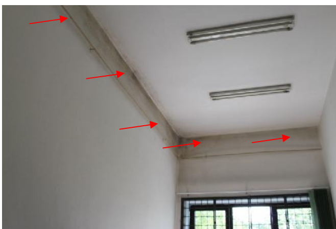
Slika 27 – Pojava kondenzata na spoju spoljašnjih zidova u osi “Q” i osi “I” i tavanice (pomoćni kabinet) (foto 35)
