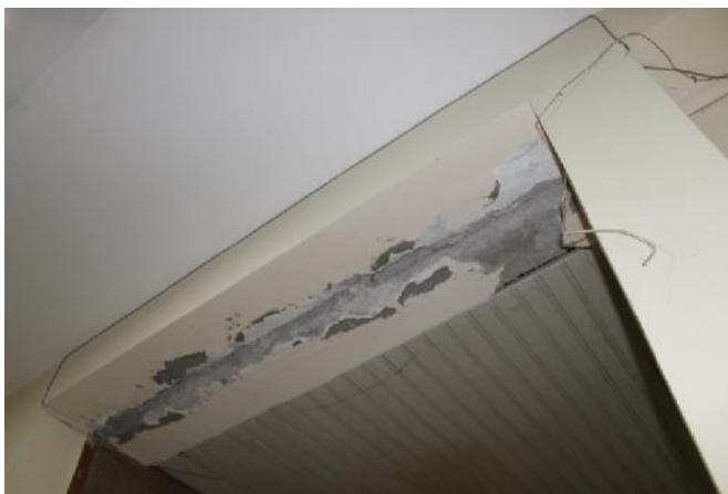
Slika 181 – Površinsko oštećenje grede i otpadanje maltera na mestu dilatacije u osi “10” između osa “L” i “M” (hodnik) (foto 193)
