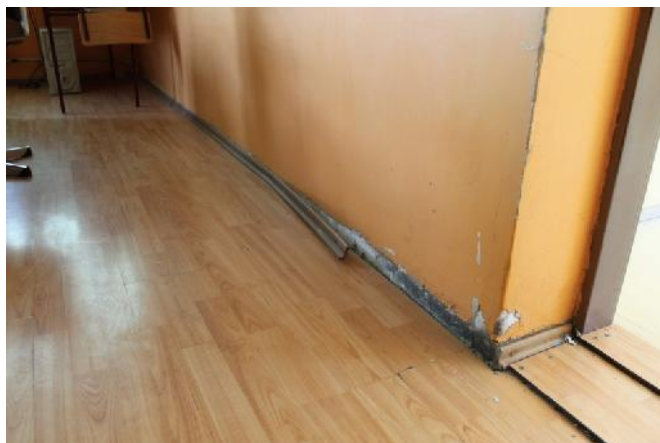
Slika 47 – Oštećenje lajsne izme u zidu u osi “Z” i podne obloge (u ionica srpskog jezika)(foto 58)
