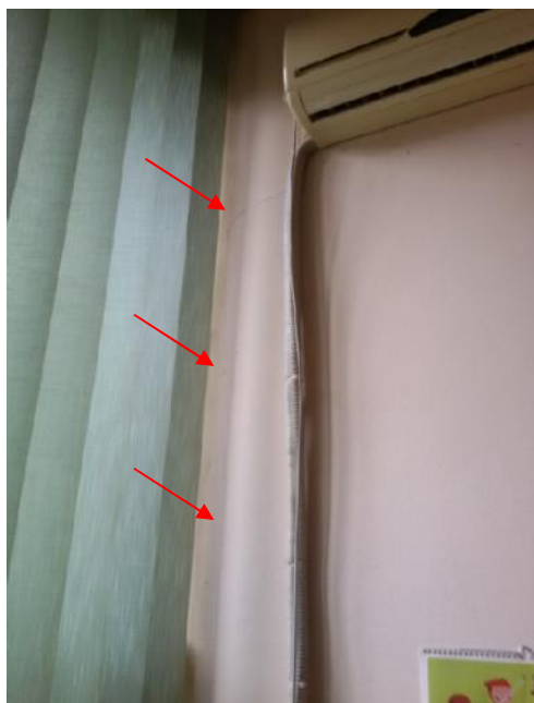
Slika 99 – Pojava vertikalne prsline na zidu u osi “I” izme u osa “10” i “11” (kancelarija sekretarice) (foto 149)
