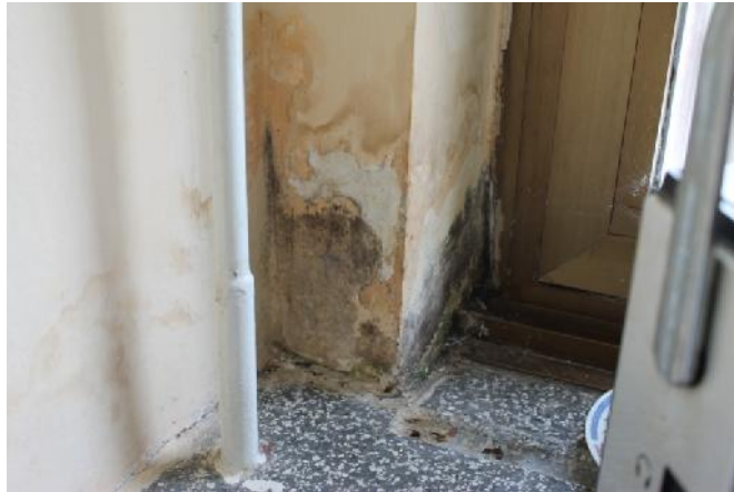
Slika 84 – Pojava vlage na stubu u osi “X” između osa “12” i “13” (ra unovodstvo) (foto 114)
