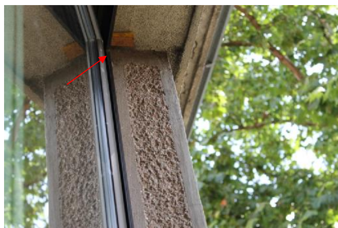
Slika 54 – Uo eni ko i i na mestu spoja otvora i prozora na zidu u osi “4” izme u osa “Z” i “Š”(u ionica srpskog jezika) (foto 65)
