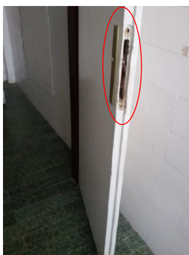
Slika 202 i Slika 203 – Ošte ena ulazna vrata i vrata pretprostora u muškom toaletu (foto 181 i 185)
