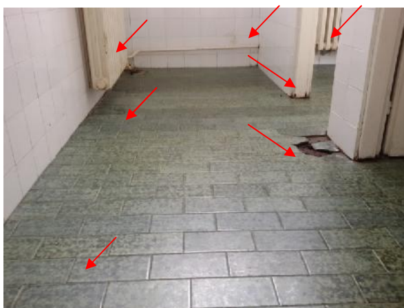
Slika 83 – Ošte ena zidna i podna keramika; vrata u lošem stanju; radijatori i cevi u lošem stanju (muški toalet za u enike) (foto 128)
