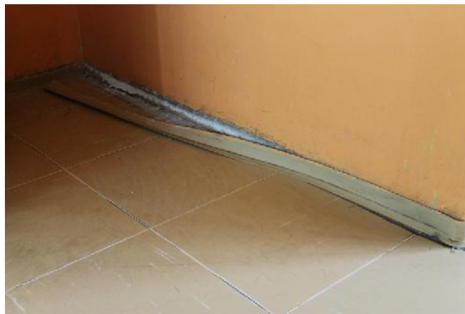
Slika 40 – Oštećenje laka izmeću zida u osi “6” i podne obloge (u ionica engleskog jezika) (foto 50)
