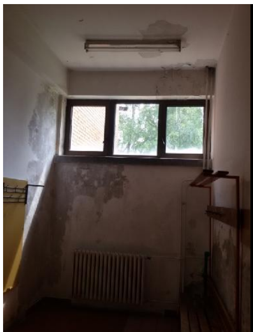
Slika 208 i Slika 209 – Oštećenja u ženskoj svla ionici - površinsko oštećenje i odlamanje maltera zida i plafona izme u osa “F” i “H” (foto 204 i foto 205)
