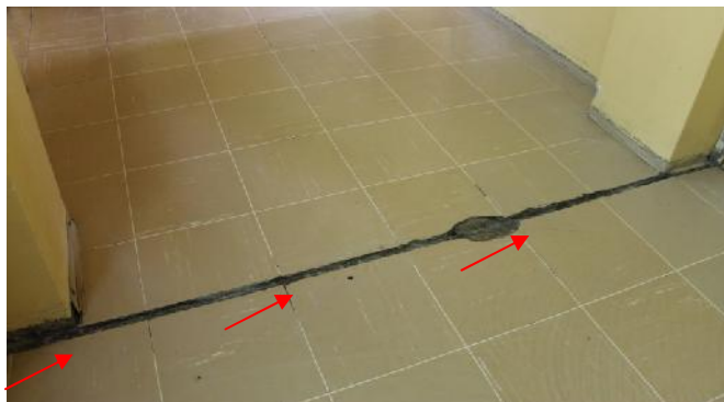
Slika 11 – Dilatacija u podu objekta u osi “G” između osa “4” i “5” (foto 16)
