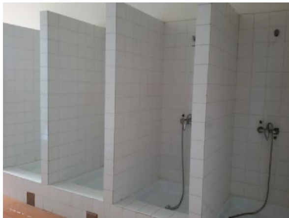
Slika 211 – Prikaz tuševa u lošem stanju – predviđeno za rušenje (tuš kabine nemaju vrata, ne postoji topla voda, tuševi nisu u funkciji) (foto 207)
