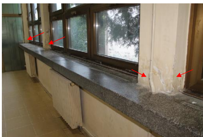
Slika 115 – Pojava vlage na svim stubovima u osi “10” kod donje ivice prozora (hodnik) (foto 236)
