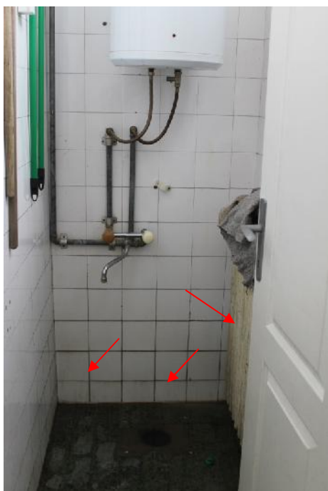
Slika 79 – Oštećenja na zidnoj i podnoj keramici; radijator i cevi u lošem stanju; odvod u lošem stanju (ženski toalet za u enike) (foto 109)
