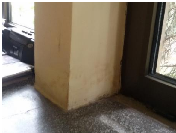
Slika 95 – Pojava vlage na stubu u osi “10” između osa “E” i “G” (kancelarija direktora) (foto 143)
