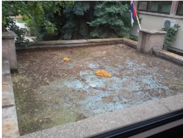
Slika 90 – Loše održavanje ravnog krova iznad ulaza u objekat (foto 123)
