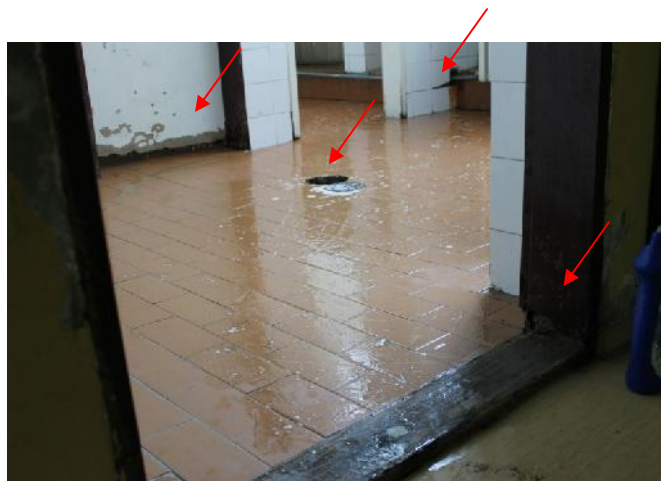
Slika 141 – Podna i zidna keramika i odvod u lošem stanju; ošte ena ulazna vrata; ošte ena vrata na ulazu u WC kabine (muški toalet) (foto 144)
