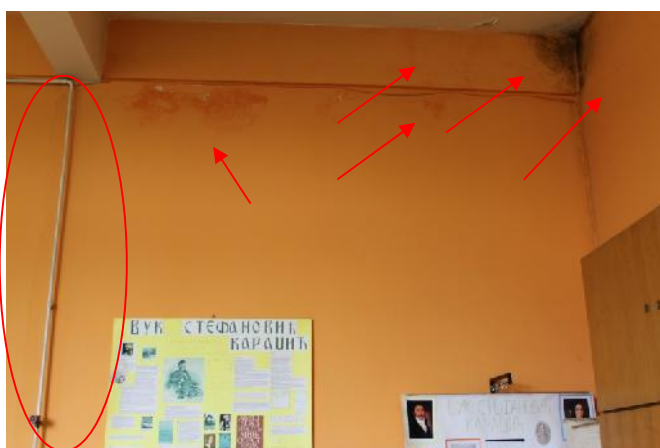
Slika 49 – Pojava kondenza na spoju spoljašnjih zidova u osi “Š” i osi “7” i tavanice; pojava vlage u zidu u osi “7” izme u osa “Z” i “Š”; pojava vertikalnih prslina na mestu stubova i horizontalnih prslina u nivou grede u osi “Š” (u ionica srpskog jezika) (foto 61)
