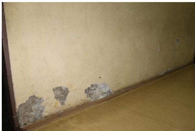
Slika 111 – Oštećenje površinskog sloja zida i odlamanje maltera u osi “11” između osa “O” i “P”; (foto 230)
