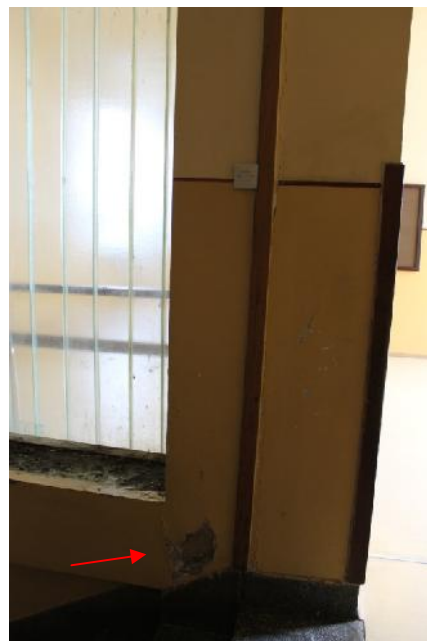
Slika 25 - Pukotina na mestu zidne dilatacije na zidu u osi “5”i otpadanje maltera u zidu u osi “Q” izme u osa “5” i “6”(foto 33)
