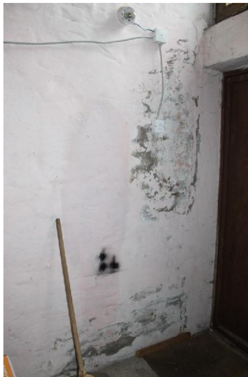
Slika 179 – Vertikalna pukotina i površinsko oštećenje zida u osi “Q” između osa “12” i “13” (radionica) (foto 191)
