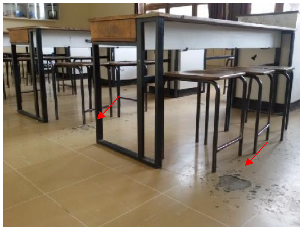
Slika 91 – Oštećenja pod – uočene rupe u cementnoj košuljici (u ionica fizike) (foto 134)
