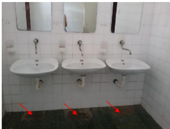
Slika 200 – Ošte ena zidna i podna keramika; umivaonici u lošem stanju u osi “P” izme u osa “11” i “12” (foto 183)
