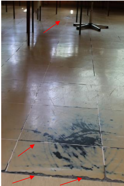
Slika 38 – Oštećenje podne obloge (u ionica engleskog jezika) (foto 48)
