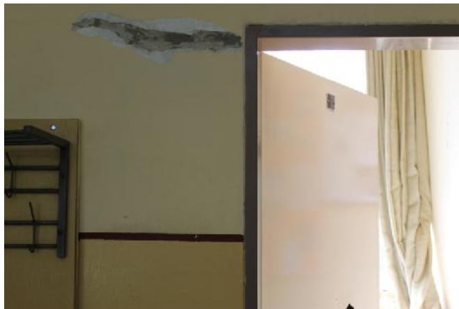
Slika 7 – Pukotina u uglu vrata po celoj širini zida (zid u osi “4”) (pomoćni kabinet) (foto 7)
