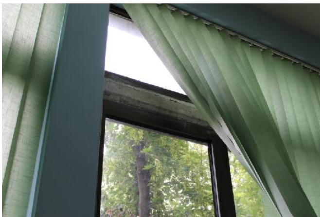
Slika 145 – Pojava vlage na horizontalnoj gredi izme u prozora u osi “3” izme u osa “S” i “V”; ošte enje površinskog sloja grede i otpadanje maltera na pojedinim mestima (u ionica III razreda) (foto 149)
