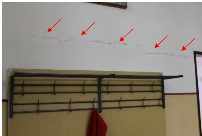
Slika 158 – Horizontalne pukotine u osi “4” izme u osa “F” i “G” (hodnik) (foto 164)
