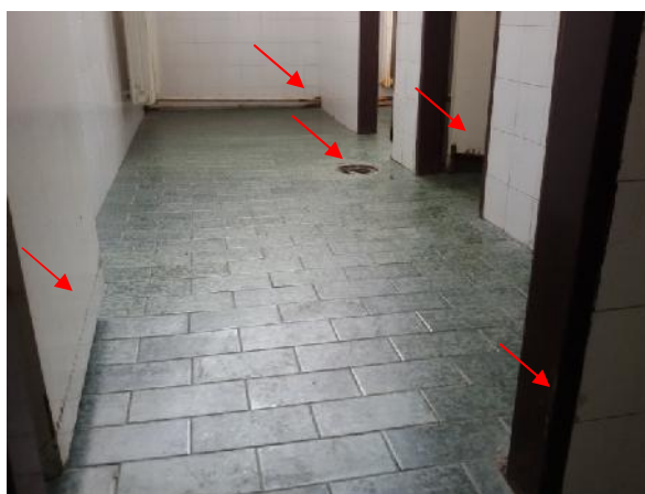
Slika 201 – Loše stanje zidne i podne keramike i odvoda u muškom toaletu izme u osa “11” i “13”; ošte ena vrata za ulaz u WC kabine (foto 184)
