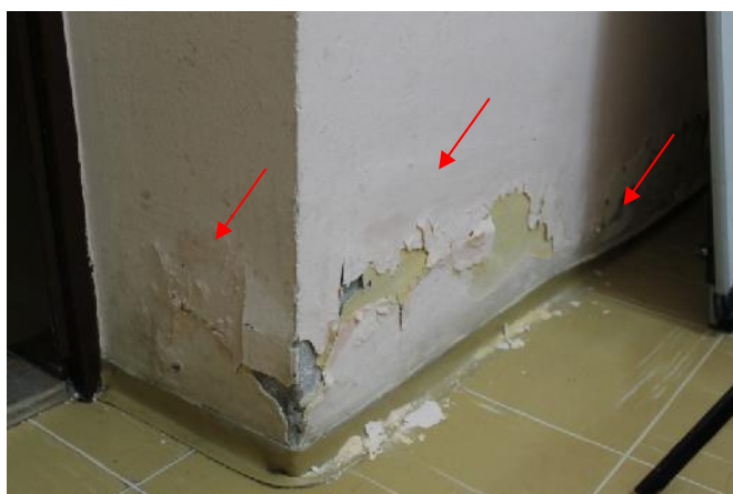
Slika 133 – Ošte ena lajsna izme u zida i poda, površinsko ošte enje i odlamanje maltera u zidu u osi “4” izme u osa “P” i “Q” (stru na služba) (foto 136)
