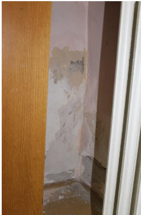
Slika 135 – Oštećenja na zidu i podu, površinska oštećenja i odlamanje maltera u zidovima u osama “Q” i “1” (stružba na službu) (foto 138)
