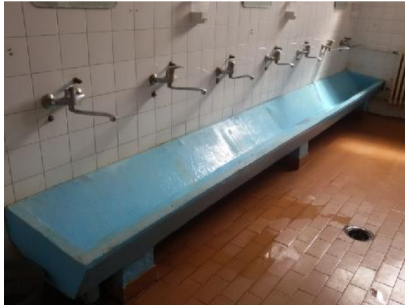
Slika 210 – Prikaz betonskog korita u lošem stanju – predviđeno za rušenje; većina slavina nije u funkciji, keramičke pločice u lošem stanju (foto 206)
