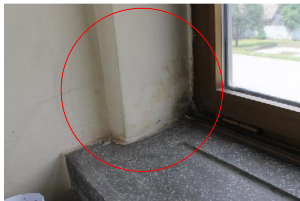
Slika 67 – Pojava vlage na zidu u osi “W” na mestu susticanja sa zidom u osi “13” (kabinet hemije) (foto 86)
