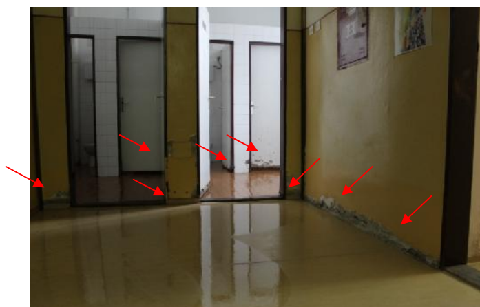
Slika 164 – Odlomljene lajsne izme u zida i poda, površinsko oštećenje i odlamanje maltera u zidovima u osama “4” i “Q”; oštećenja vrata i pragovi u toaletima (hodnik – pogled na muški i ženski toalet) (foto 173)
