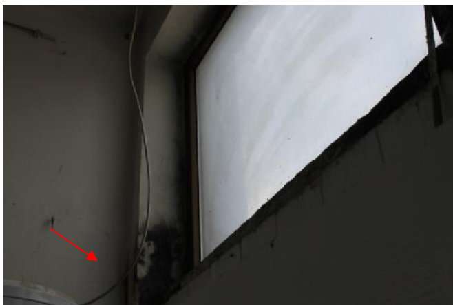
Slika 81 – Pojava kondenza na spoju zidova u osi “P” i “13” (ženski toalet za u enike) (foto 110)
