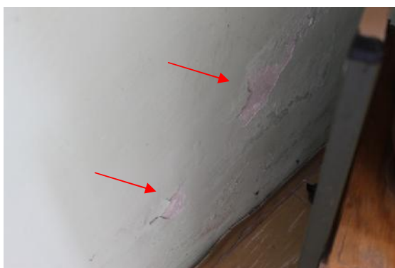
Slika 73 – Ošte enje površinskog sloja zida i deformacija podne lajsne (pomo ni kabinet) (foto 99)
