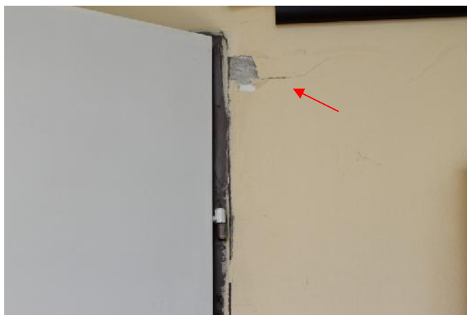
Slika 8 – Pukotina u uglu vrata po celoj širini zida (zid u osi “4”) (pomoćni kabinet) (foto 8)
