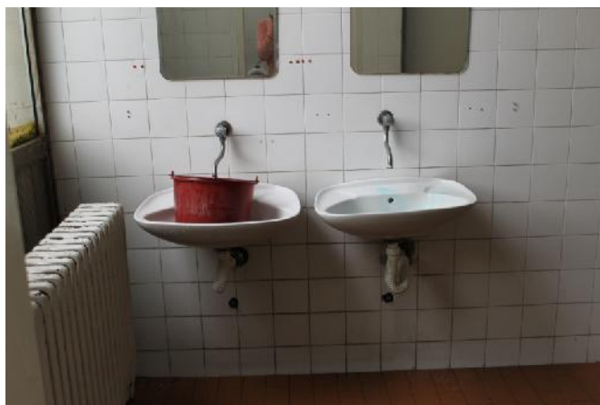
Slika 138 – Umivaonici nisu u funkciji; zidna i podna keramika u lošem stanju (muški toalet) (foto 140)
