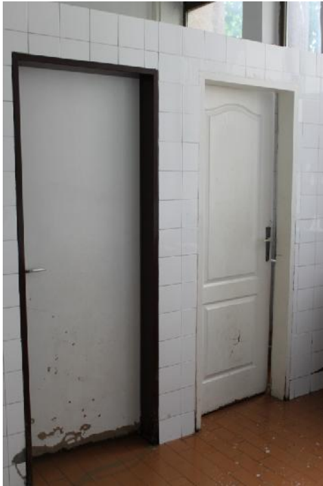
Slika 139 – Polomljena vrata na ulazu u WC kabine (muški toalet) u osi “S”; podna keramika u lošem stanju (foto 142)
