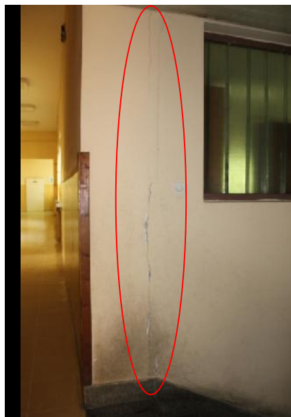
Slika 21 - Pukotina na mestu zidne dilatacije na zidu u osi “5”(foto 29)
