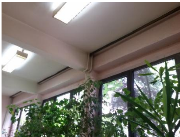
Slika 213 – Pojava kondenza na mestu horizontalne grede iznad prozora u zidu u osi “10” izme u osa “F” i “H”(trpezarija) (foto 234)
