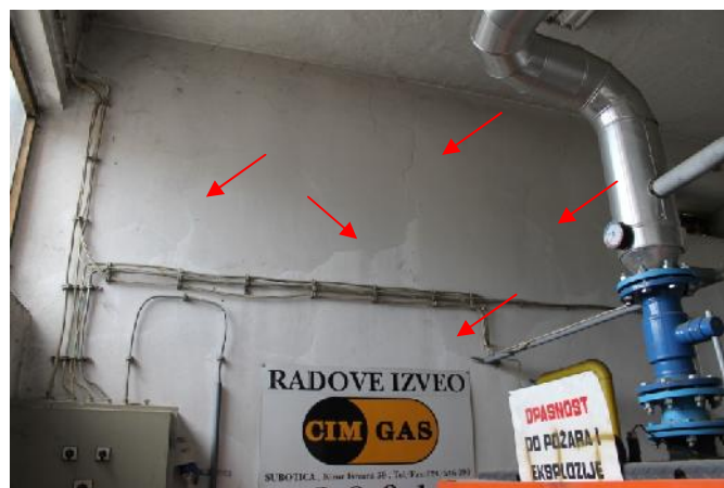
Slika 177 – Mrežaste prsline u zidu u osi “Y” (kotlarnica) (foto 187)
