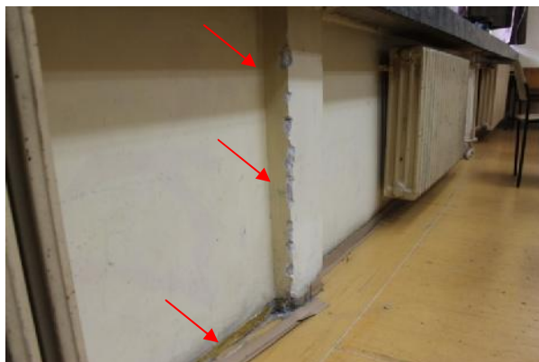
Slika 62 – Odlamanje maltera stuba u osi “T” izme u osa “8” i “9” i ošte ena lajsna na mestu spoja zida u osi “T” i podne obloge(u ionica likovnog) (foto 81)
