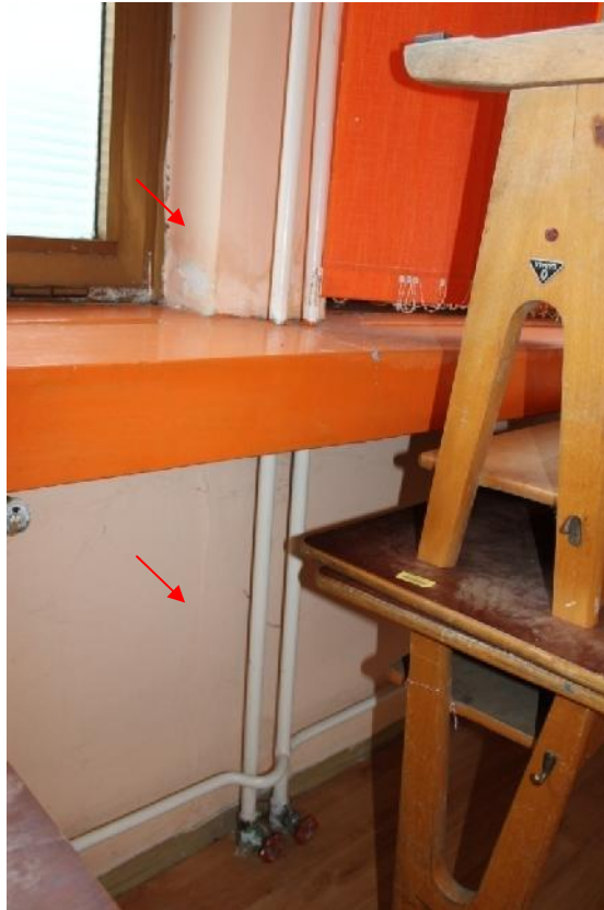
Slika 170 – Pojava vlage na svim stubovima u osi “10” izme u osa “T” i “X” kod donje ivice prozora; vertikalna prslina na mestu stuba po celoj visini parapet (hodnik – produženi boravak) (foto 179)
