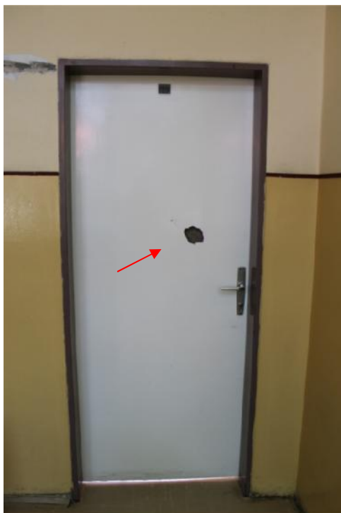
Slika 9 – Pukotina u uglu vrata po celoj širini zida (zid u osi “4”) i rupa na vratima (pomo ni kabinet) (foto 14)
