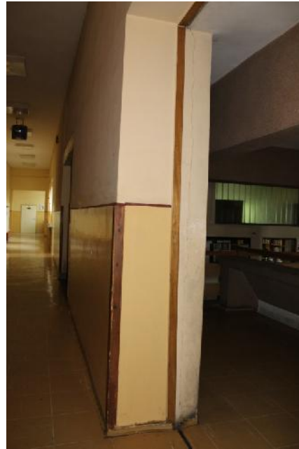
Slika 23 - Pukotina na mestu zidne dilatacije na zidu u osi “5”(foto 31)
