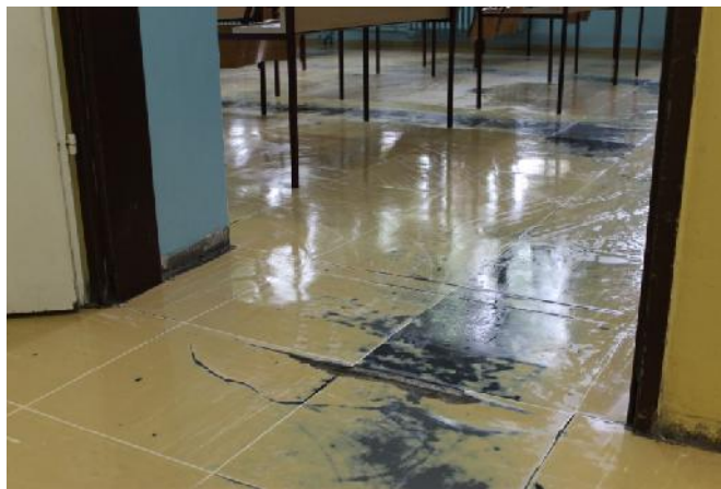
Slika 124 – Odlomljena lajsna izme u zida i poda i ošte enje poda (u ionica I i II razreda) (foto 125)
