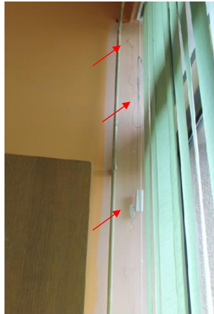
Slika 39 – Vertikalna prslina na spoju zidova u osi “3” i “V” (u ionica engleskog jezika) (foto 51)
