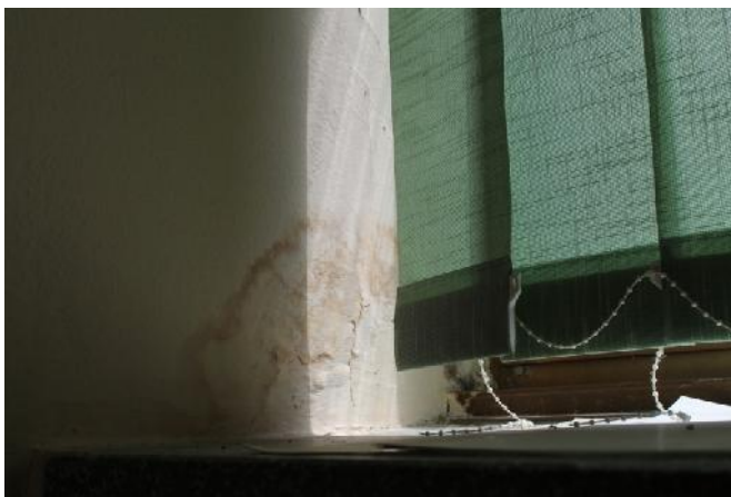
Slika 88 – Pojava vlage na zidu u osi “Y” na spoju sa zidom u osi “10” (ra unovodstvo) (foto 118)
