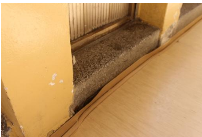
Slika 28 – Oštećenje lajsne između zida u osi “3” i podne obloge (foto 39)
