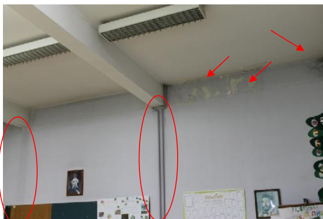
Slika 150 – Pojava kondenza na spoju spoljašnjih zidova u osi “Š” i osi “7” i tavanice; pojava vlage u zidu u osi “7” izme u osa “Z” i “Š”; pojava vertikalnih prslina na mestu stubova i horizontalnih prslina u nivou grede u osi “7” (u ionica III razreda) (foto 154)
