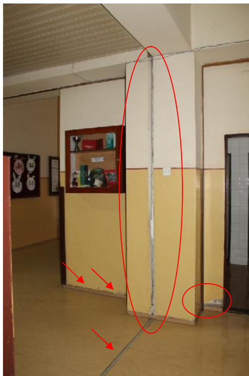
Slika 165 – Prikaz dilatacije objekta; oštećenje lajsne izme u zidu i poda, površinsko oštećenje i odlamanje maltera u zidu u osi "Q" izme u osa "4" i "6" (hodnik) (foto 174)
