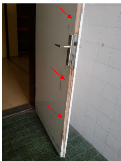
Slika 202 i Slika 203 – Ošte ena ulazna vrata i vrata pretprostora u muškom toaletu (foto 181 i 185)
