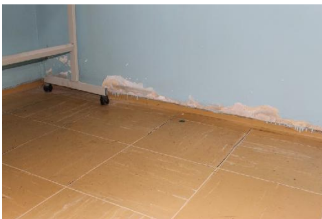
Slika 126 – Ošte ena lajsna izme u zida u osi “J” izme u osa “1” i “2” i poda; površinsko ošte enje zida i odlamanje maltera (u ionica I i II razreda) (foto 127)
