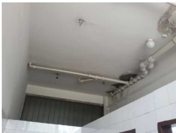
Slika 196 – Površinsko oštećenje i odlamanje maltera zidova i plafona izme u osa “11” i “13” (foto 175)
